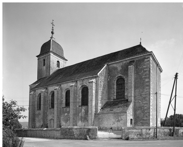
Façade latérale droite. Phot. Yves Sancey IVR43_19777000326V
