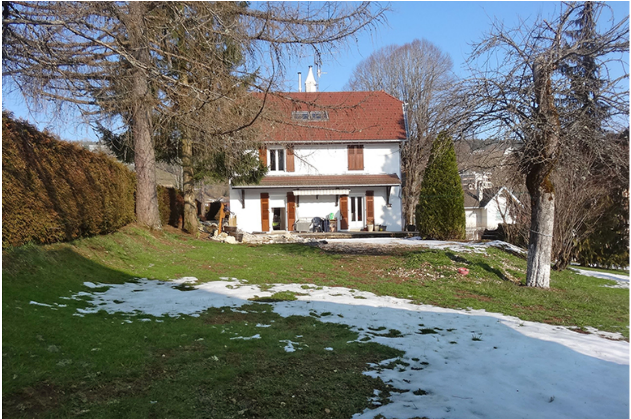
[Façade postérieure de la maison, 14 mars 2013].
