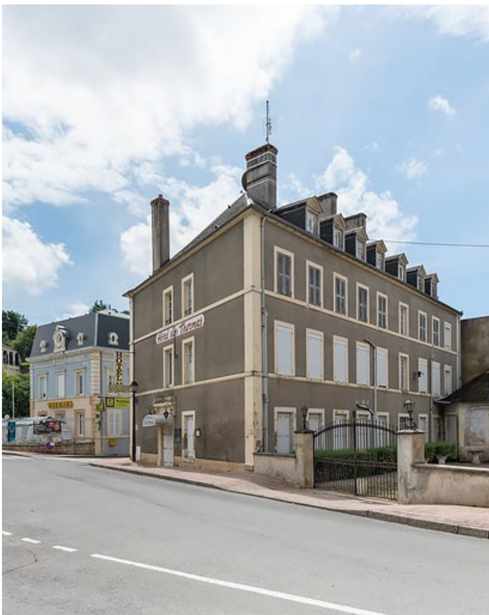
Façade est et façade nord.
