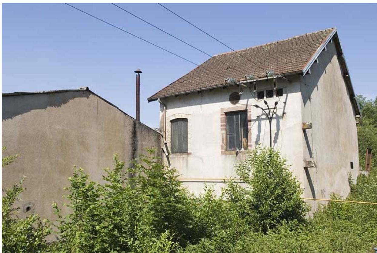
Bâtiment d'eau, actuellement transformateur.
