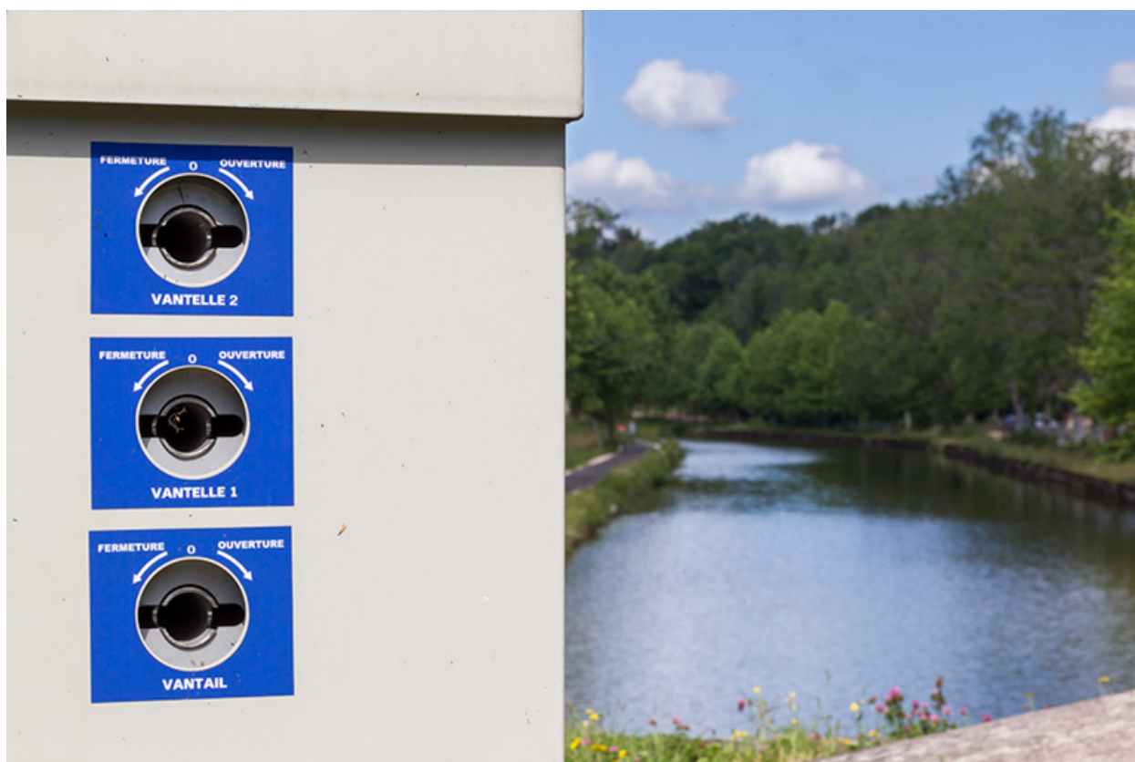
Commandes pour l'ouverture et la fermetures du vantail et des vanteilles.
