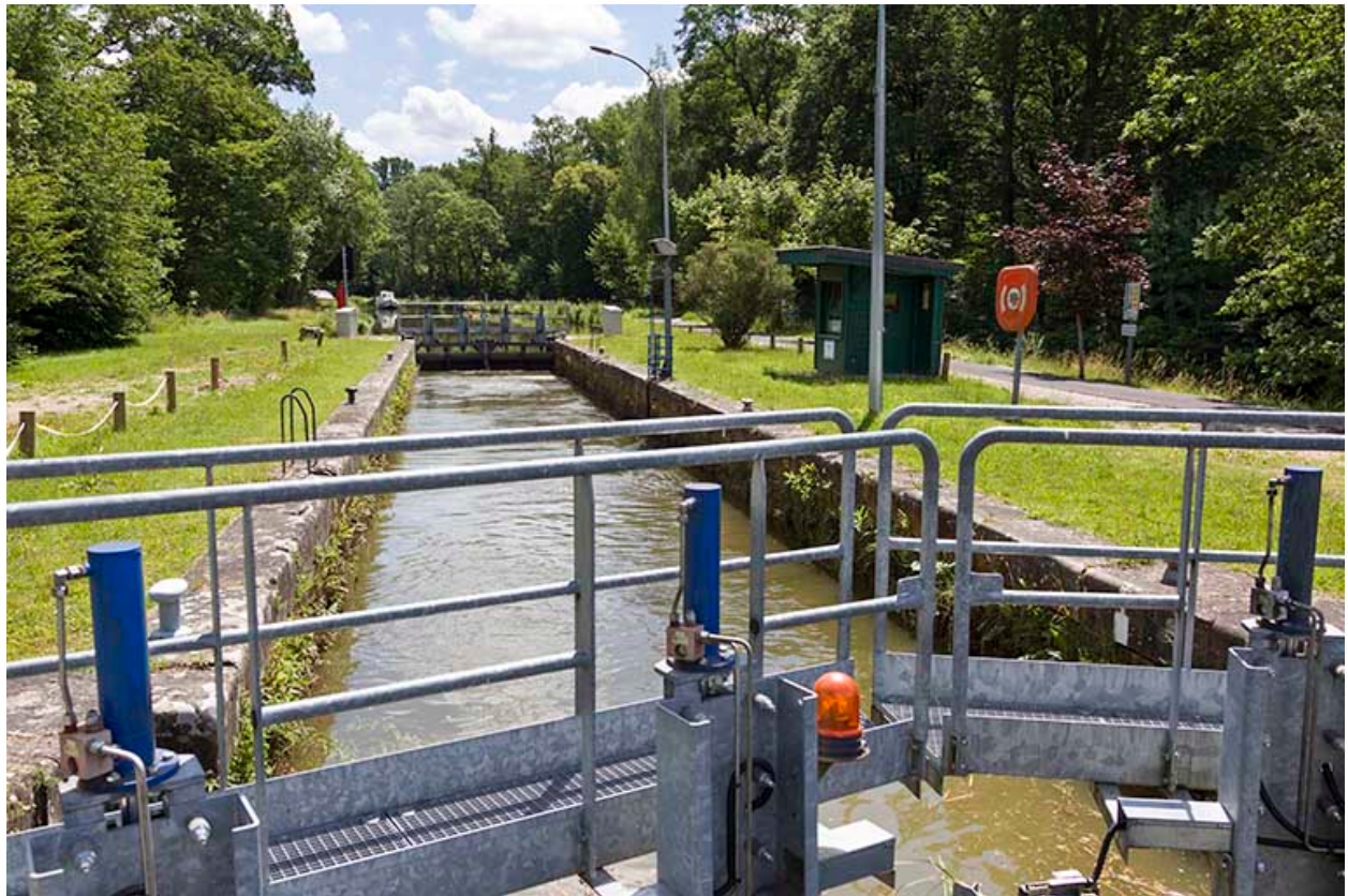
L'écluse, depuis la passerelle.
