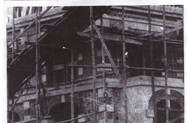
La construction de la demeure. Phot. Jérôme Mongreville IVR43_20067000202NUCA
