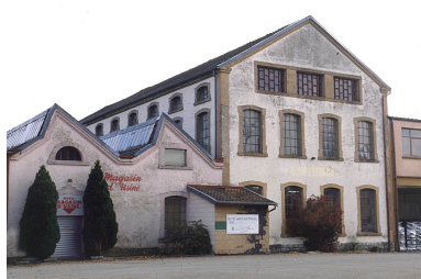
Pignons des façades antérieures.
