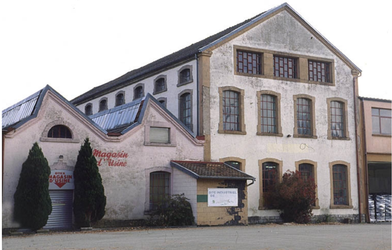
Pignons des façades antérieures.
