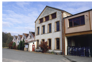
Façades antérieures depuis le sud.
