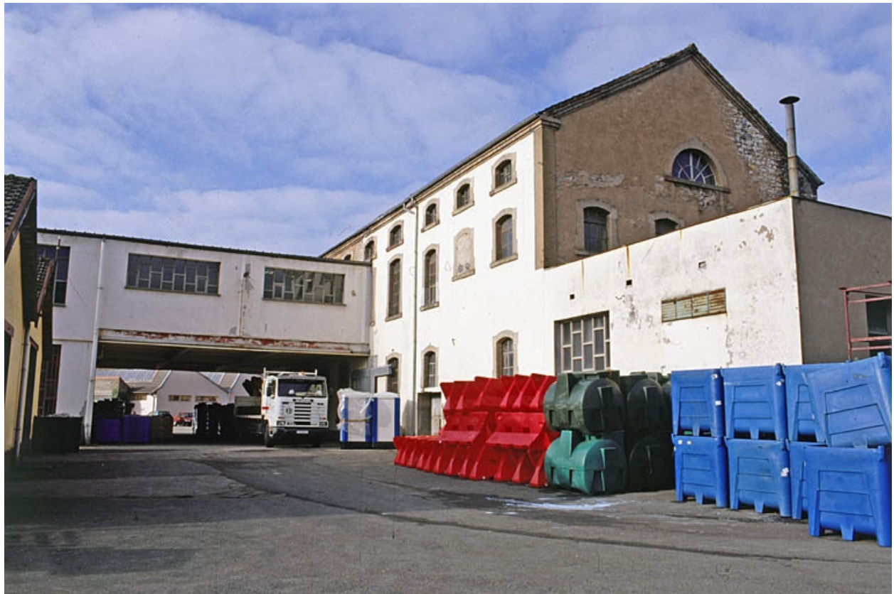
Façade postérieure des ateliers de fabrication.
