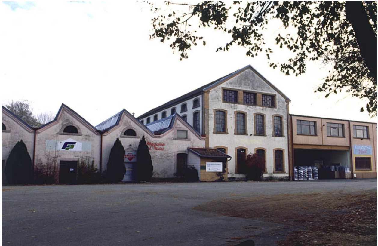
Façades antérieures vues de trois quarts.
