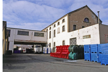
Façade postérieure des ateliers de fabrication.
