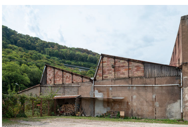
Murs-pignons des ateliers. Phot. Jérôme Mongreville IVR43_20182501296NUC4A
