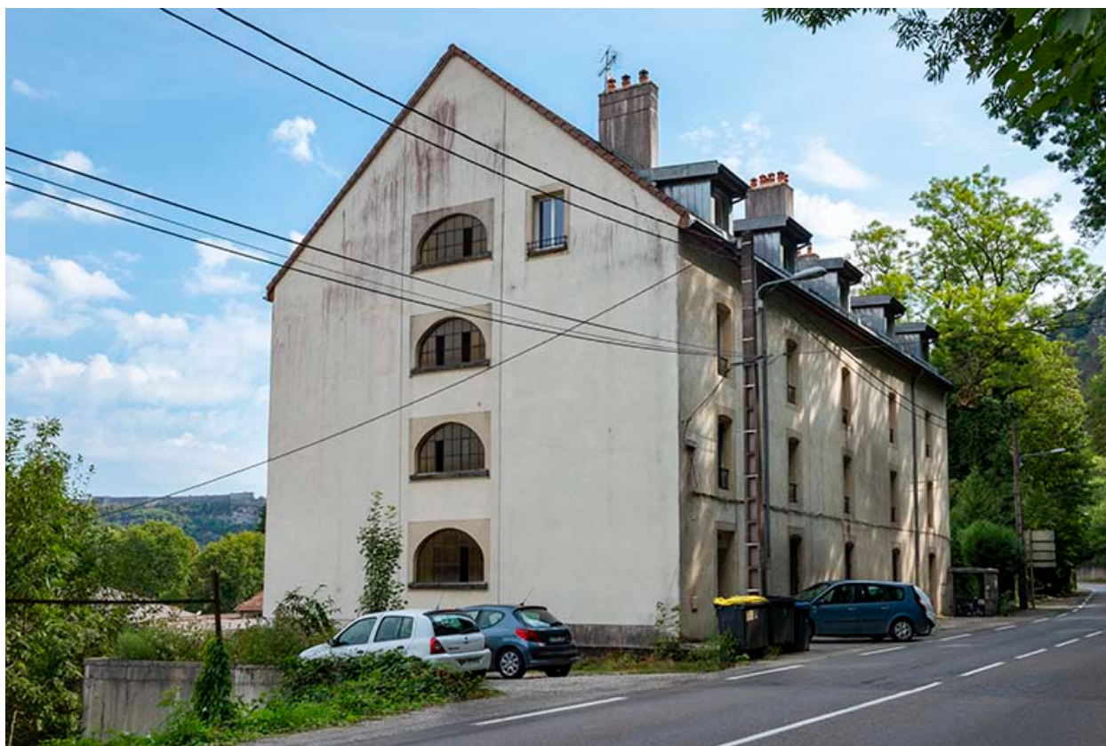
Logement ouvrier vu de trois quarts gauche.
