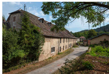
Atelier de fonderie vu de trois quarts arrière. Phot. Jérôme Mongreville IVR43_20182501286NUC4A
