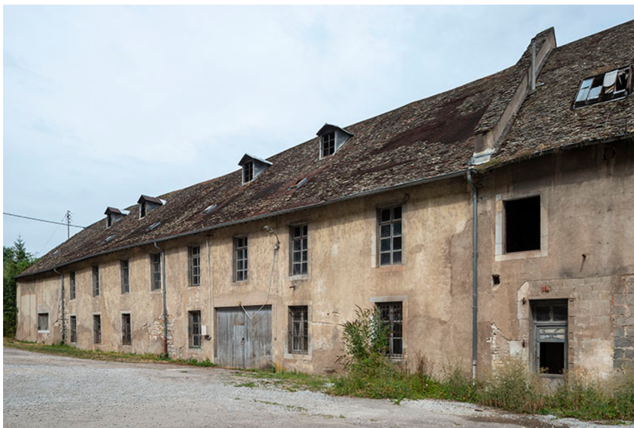
Façade sud de l'atelier de fonderie.
