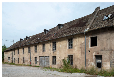
Façade sud de l'atelier de fonderie. Phot. Jérôme Mongreville IVR43_20182501292NUC4A
