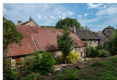
Façades sud des écuries, remises et logements.
