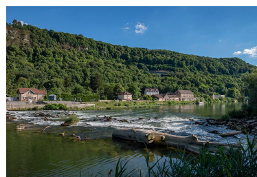
Vue d'ensemble depuis le nord-est (cadrage horizontal). Phot. Jérôme Mongreville IVR43_20182501282NUC4A
