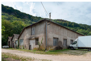
Garages et entrepôts industriels (faïencerie). Phot. Jérôme Mongreville IVR43_20182501297NUC4A
