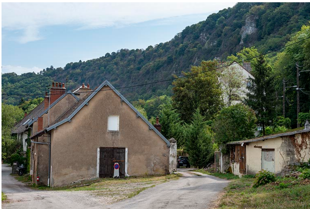
Ecurie et remises depuis l'ouest.
