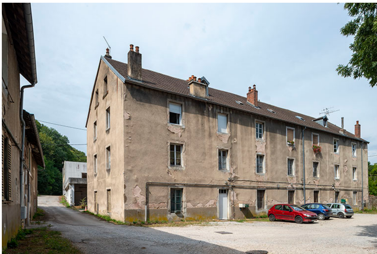
Logement ouvrier vu depuis la cour.
