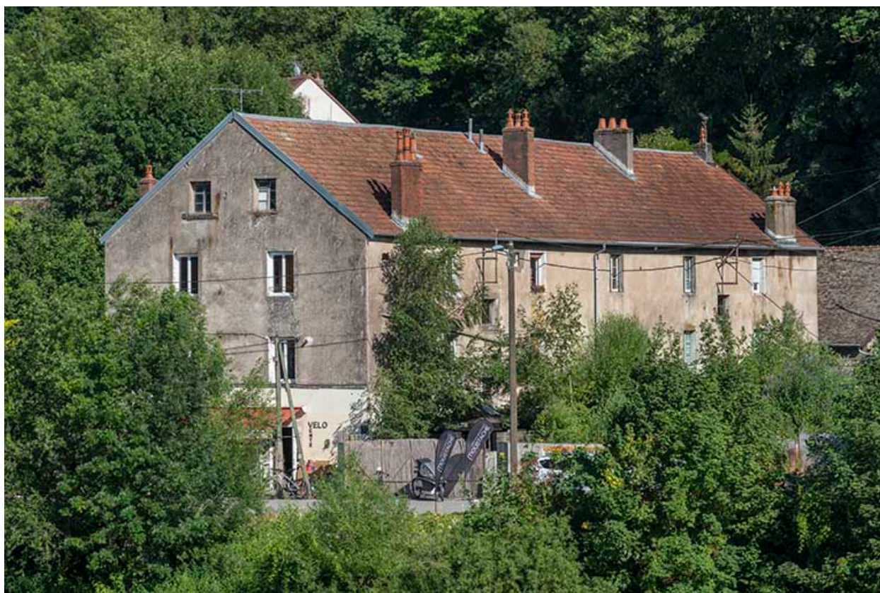
Logement ouvrier. Vue depuis le nord-ouest.
