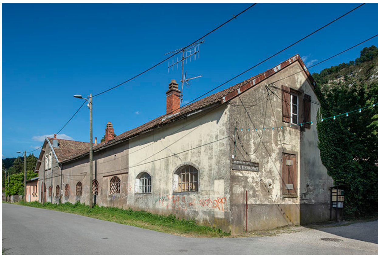
Bâtiments de la faïencerie (magasin ?).
