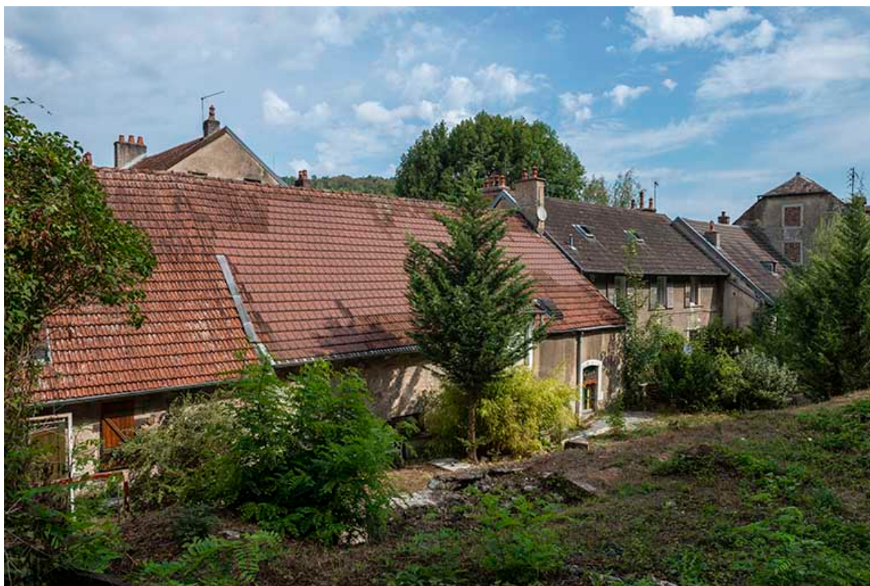
Façades sud des écuries, remises et logements.
