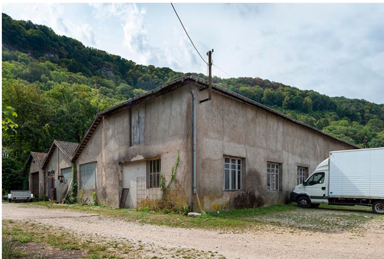
Garages et entrepôts industriels (faïencerie).
