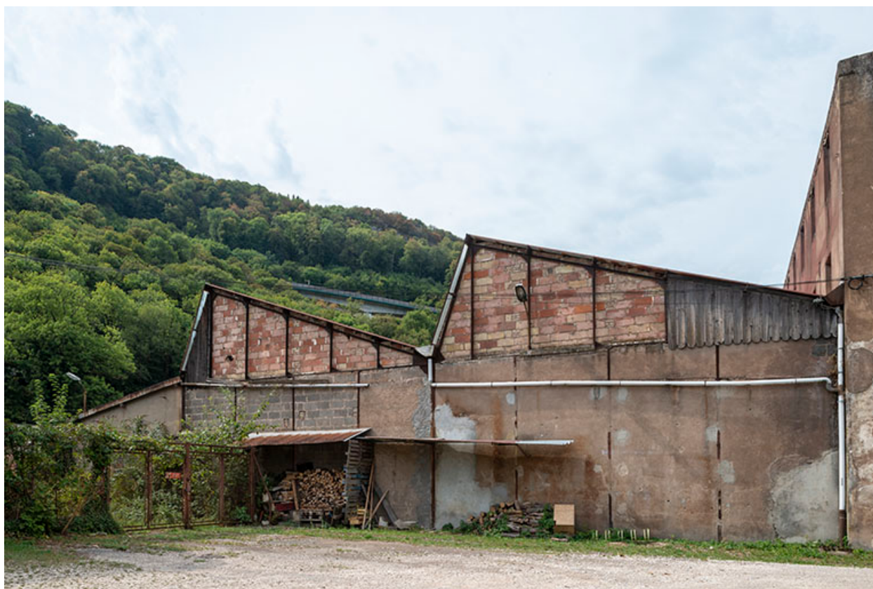
Murs-pignons des ateliers.
