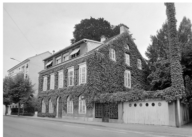
Vue d'ensemble prise de la rue du Faubourg. Phot. Jérôme Mongreville IVR43_19872500371X
