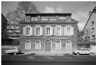
Façade sur rue. Phot. Jérôme Mongreville IVR43_19882500039V
