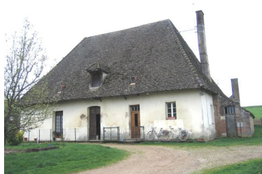
Vue d'ensemble de la façade.
