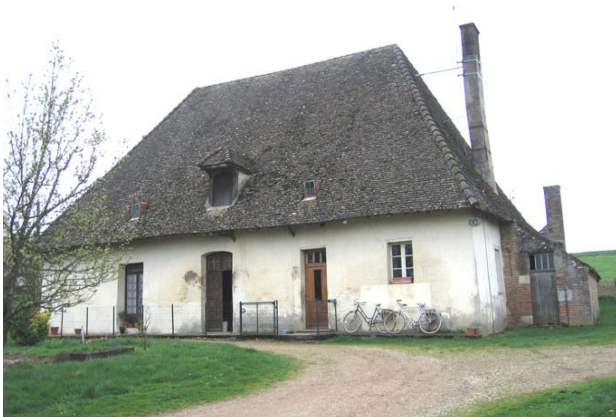
Vue d'ensemble de la façade.
