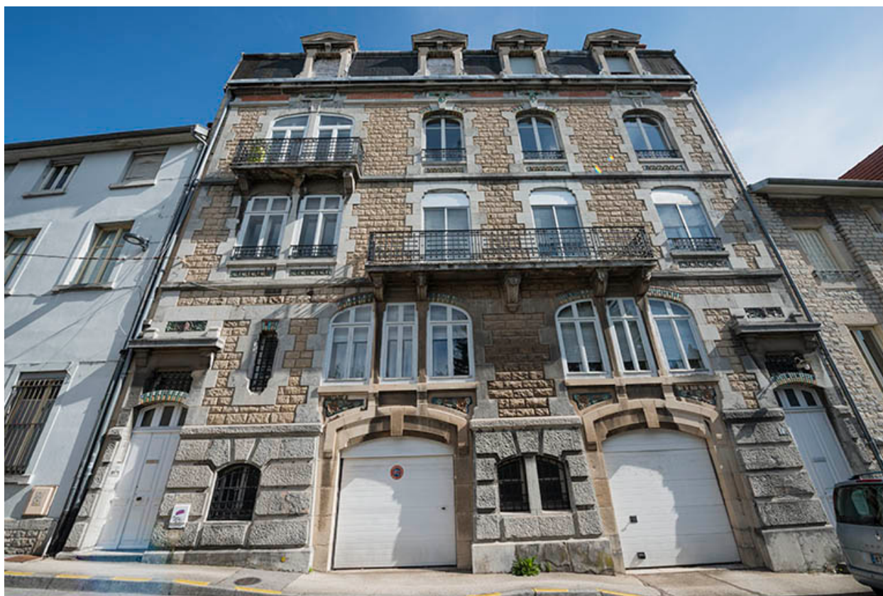
Façade antérieure. Vue en contre-plongée.
