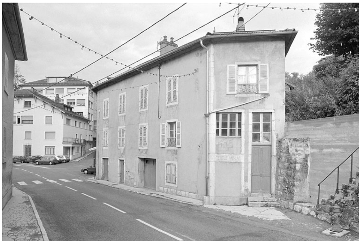
Façade sur la rue.
