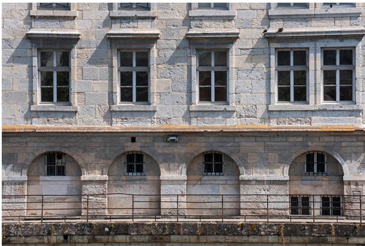
Façade postérieure : travée centrale et trois travées de gauche.
