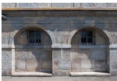
Façade postérieure : deux arcs partiellement murés. Phot. Jérôme Mongreville IVR43_20162501435NUC4A
