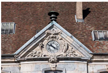
Avant-corps central : fronton. Phot. Jérôme Mongreville IVR43_20162501470NUC4A
