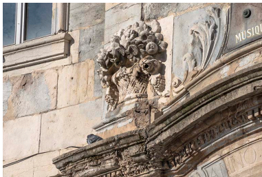
Portail : corbeille de gauche. Phot. Jérôme Mongreville IVR43_20162501467NUC4A
