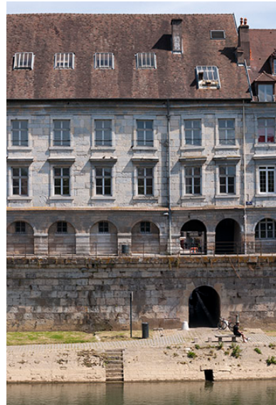
Façade postérieure : partie droite avec débouché du passage couvert sur le quai et sur le chemin de halage (cadrage vertical). Phot. Jérôme Mongreville IVR43_20162501431NUC4A
