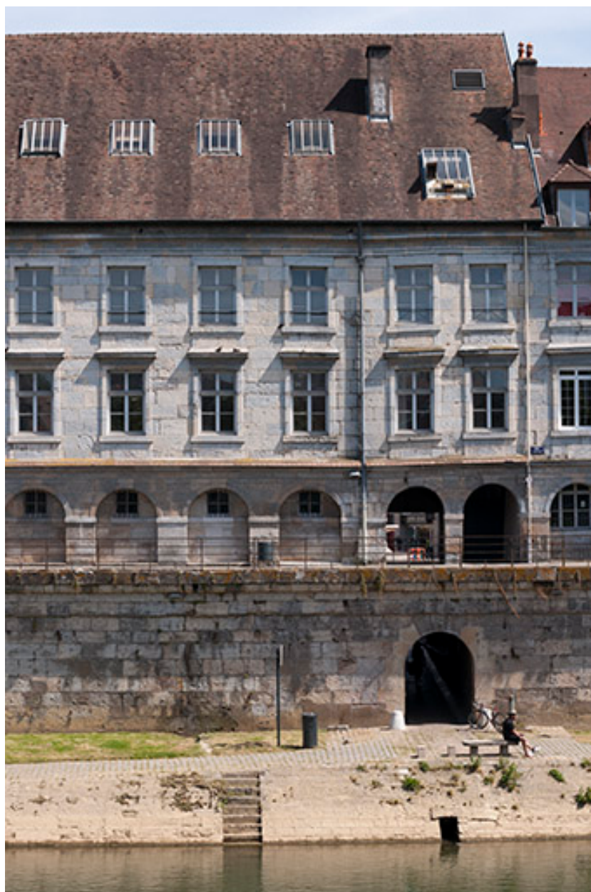
Façade postérieure : partie droite avec débouché du passage couvert sur le quai et sur le chemin de halage (cadrage vertical).
