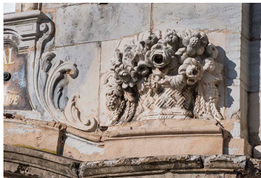
Portail : corbeille de droite. Phot. Jérôme Mongreville IVR43_20162501468NUC4A
