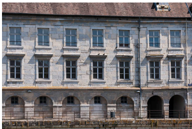
Façade postérieure : partie droite avec débouché du passage couvert sur le quai. Phot. Jérôme Mongreville IVR43_20162501430NUC4A
