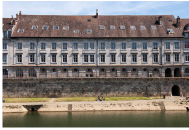
Façade postérieure. Phot. Jérôme Mongreville IVR43_20162501427NUC4A
