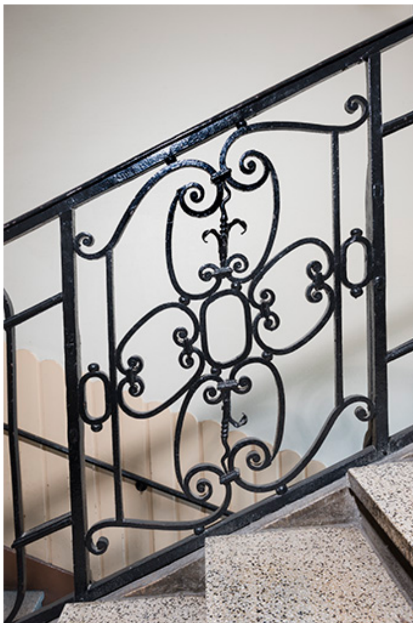
Grand escalier : motif central du garde-corps.
