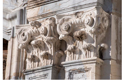
Portail : chapiteaux composites. Phot. Jérôme Mongreville IVR43_20162501472NUC4A
