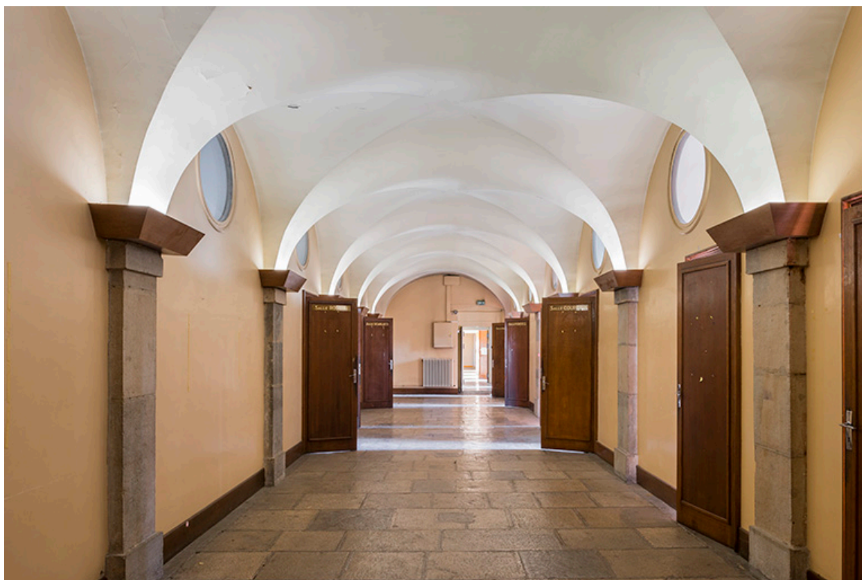
Premier étage, partie gauche : couloir central voûté.
