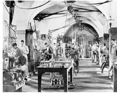
Année scolaire 1916-1917 [l'atelier de mécanique]. Phot. Yves Sancey IVR43_20042500113X
