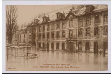
Inondations des 20-21 janvier 1910. 17 bis. - Besançon. - Place du marché - Ecole d'Horlogerie. Phot. Yves Sancey, Autr. Gratel IVR43_20102500013NUC2A
