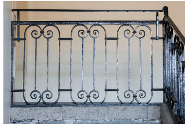
Grand escalier : garde-corps du dernier palier. Phot. Jérôme Mongreville IVR43_20162501455NUC4A
