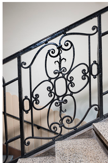
Grand escalier : motif central du garde-corps.
