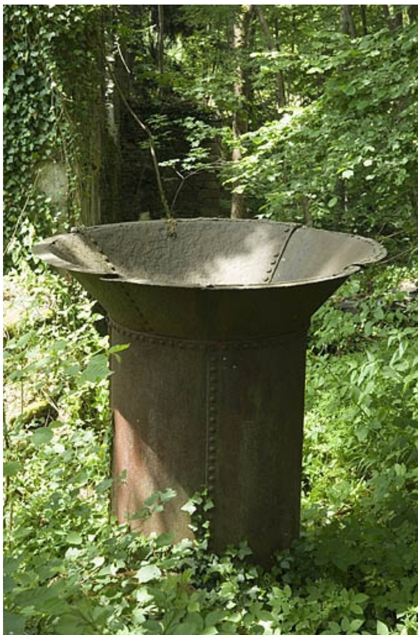
Couronnement métallique d'une cheminée en tôle.
