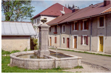
Vue de trois quarts du bassin. Phot. Yves Sancey IVR43_19993900189ZA
