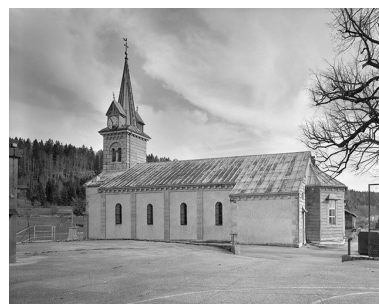
Façade latérale droite. Phot. Jérôme Mongreville IVR43_20003900594V
