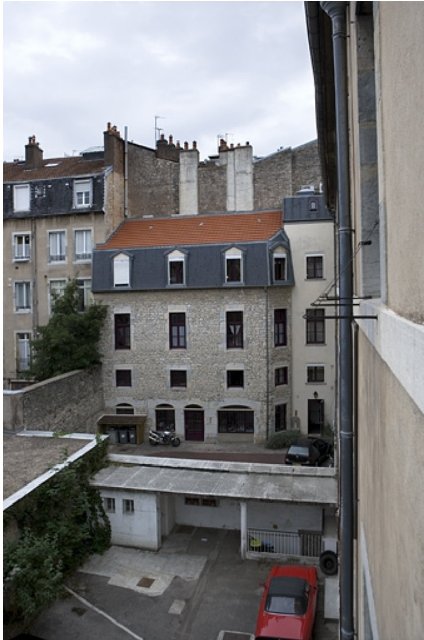
Vue d'ensemble de l'aile droite sur cour.
