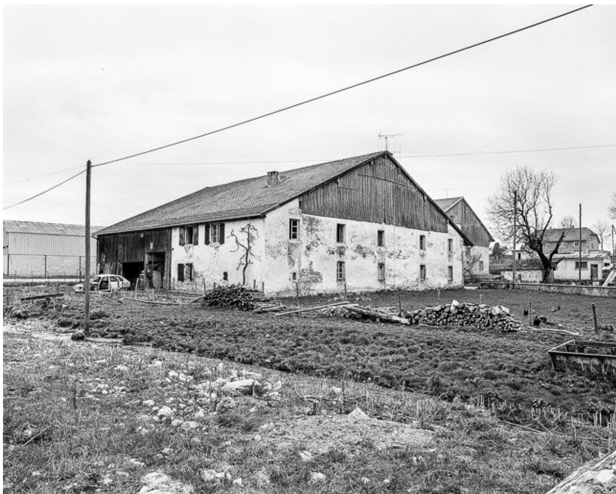
Façades postérieure et latérale gauche.
