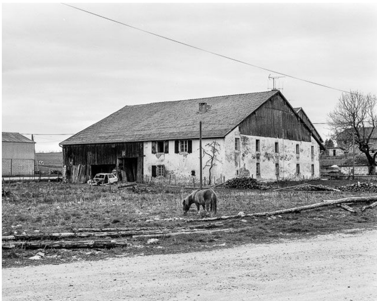
Façades postérieure et latérale gauche.
