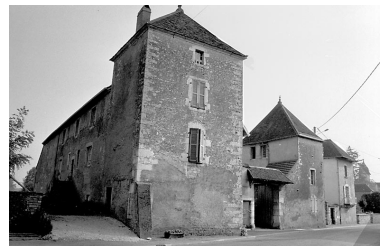
Vue de trois quarts gauche. Phot. Bernard Lardière IVR43_19797000114Z
