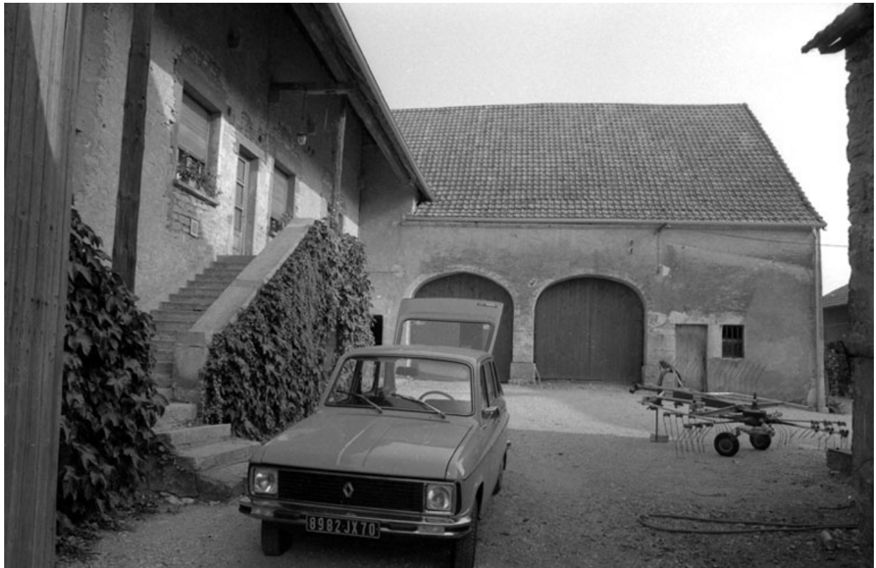
Bâtiment agricole dans la cour.
