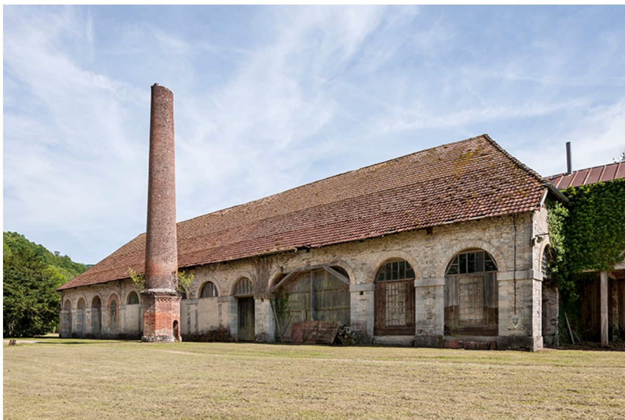
Tuilerie du Schiste, à Lods : atelier de fabrication.
