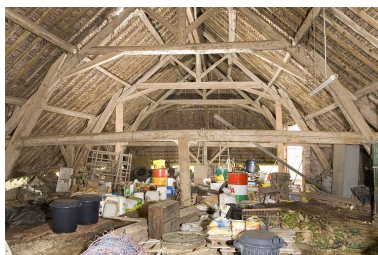
Tuilerie et briqueterie, Champtonnay : charpente du séchoir. Phot. Jérôme Mongreville IVR43_20097000146NUC2A
