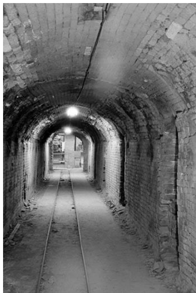
Briqueterie et tuilerie Emile Jacob, Commenailles : ancien four Hoffmann. Phot. Laurent Poupard IVR43_19893900053Z
