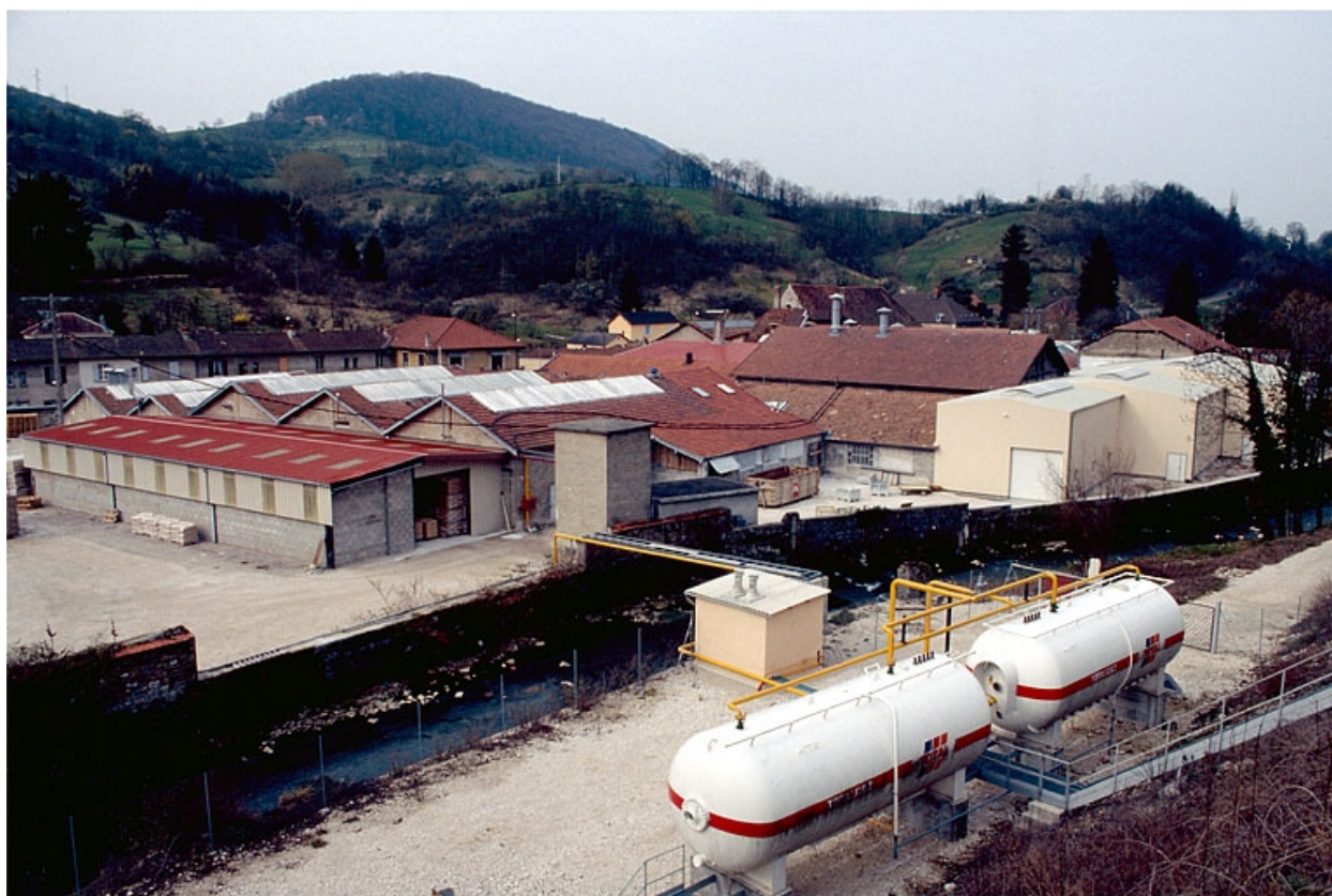
Faïencerie des Capucins, Salins-les-Bains.
