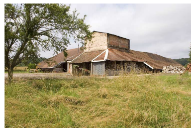
Tuilerie et briqueterie Janicot, Montureux-et-Prantigny. Le bâtiment du four s'élève à la jonction de l'atelier de fabrication (à gauche) et du séchoir (à droite). Phot. Jérôme Mongreville IVR43_20087000764NUC2A
