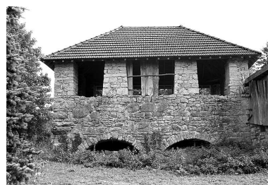
Poterie, faïencerie et tuilerie de Nermier, Sarrogna : le bâtiment du four. Phot. Laurent Poupard IVR43_19933900545Z
