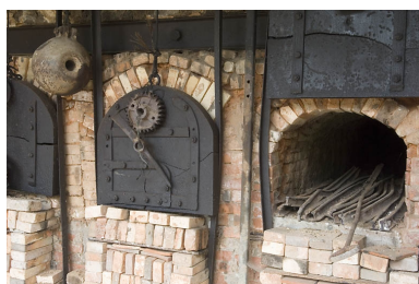
Tuilerie et briqueterie Janicot, Montureux-et-Prantigny. Gueules de charge du four, avec système d'ouverture à contrepoids. Phot. Jérôme Mongreville IVR43_20087000762NUC2A
