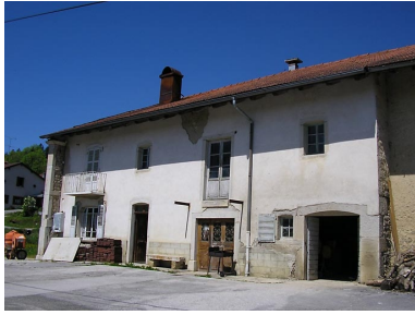
Façade antérieure vue de trois quarts.
