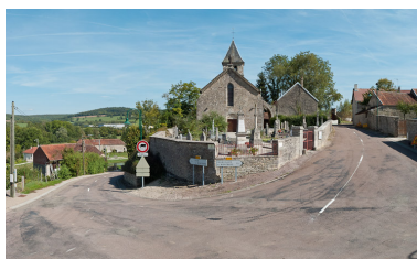
Vue de l'église. Phot. Pierre-Marie Barbe-Richaud IVR26_20112104126NUC4AQ
