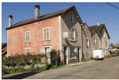
Vue de trois quarts depuis la route. Phot. Jérôme Mongreville IVR43_20067000831NUCA
