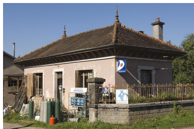
Bureaux. Phot. Jérôme Mongreville IVR43_20067000833NUCA
