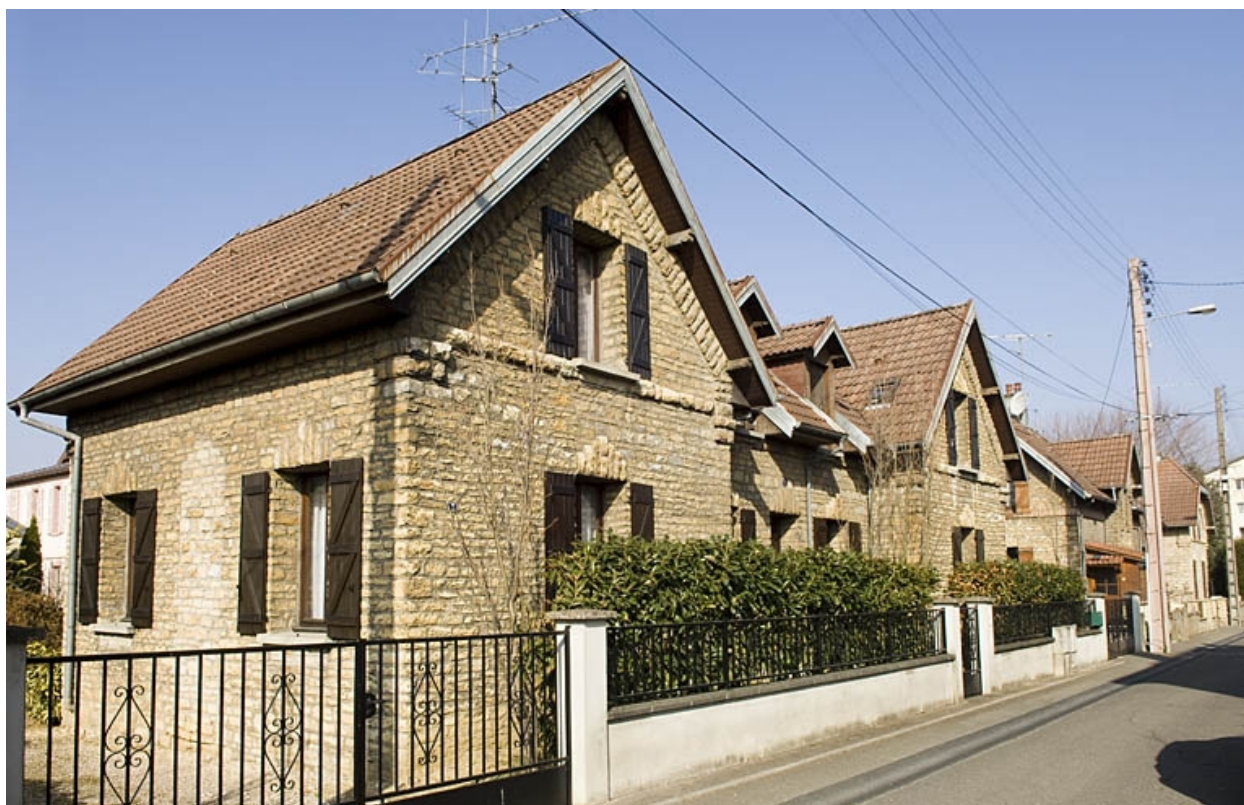
Maison à trois logements.
