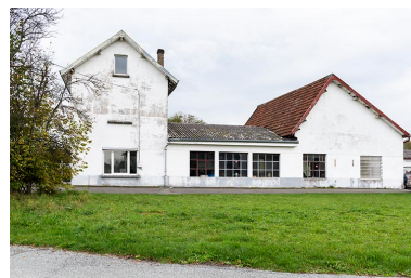
Bâtiments nord : façade latérale droite. Phot. Sonia Dourlot
