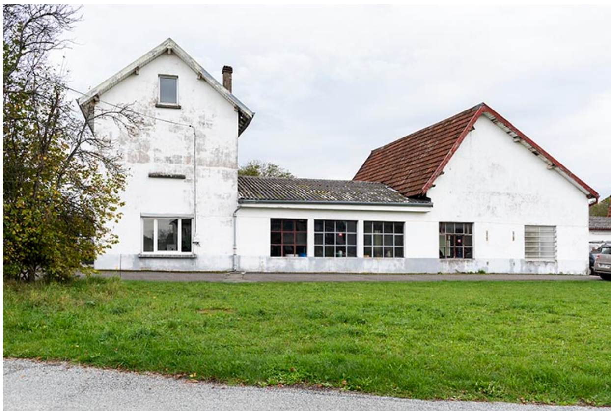
Bâtiments nord : façade latérale droite.
