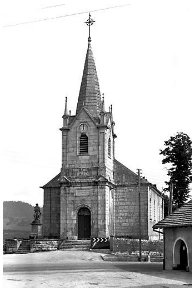
Façades antérieure et latérale droite.
