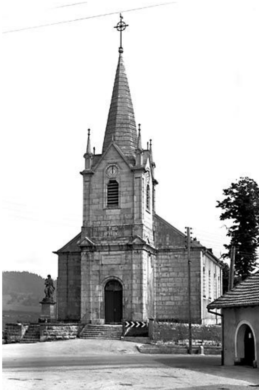
Façades antérieure et latérale droite.
