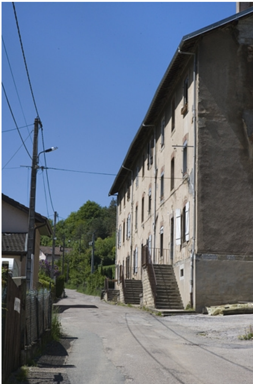
Logement d'ouvriers (rue du Tâtre). Façade antérieure.
