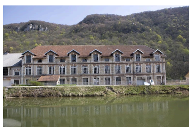
Façade antérieure de l'atelier de façonnage.
