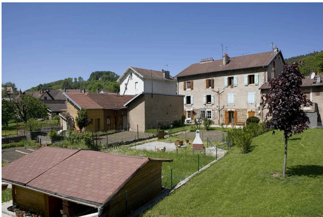
Ecole ménagère et logement d'ouvriers. Façade postérieure.
