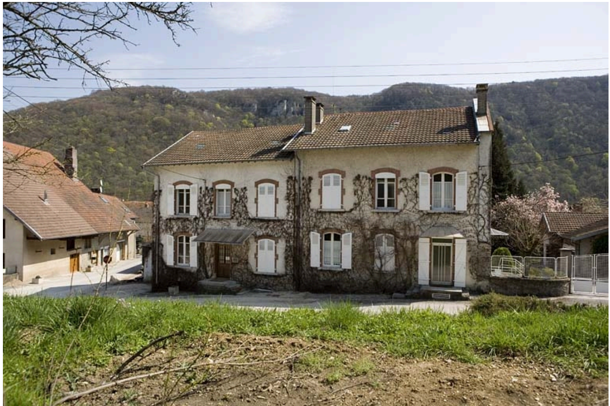
Logement patronal. Vue de la façade arrière.
