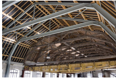
Atelier de préparation de la pâte. Reprise contemporaine de la charpente par fermes métalliques. Phot. Yves Sancey IVR43_20092500364NUC2A
