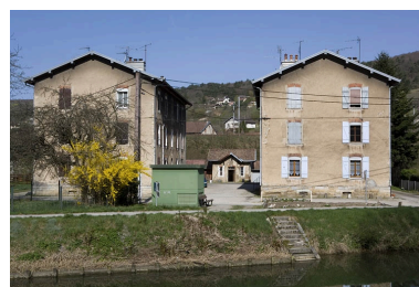
Cité ouvrière (rue des Ecoles). Pignons est.
