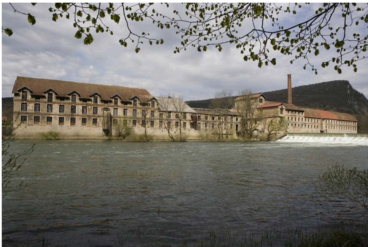
Vue d'ensemble depuis l'aval.
