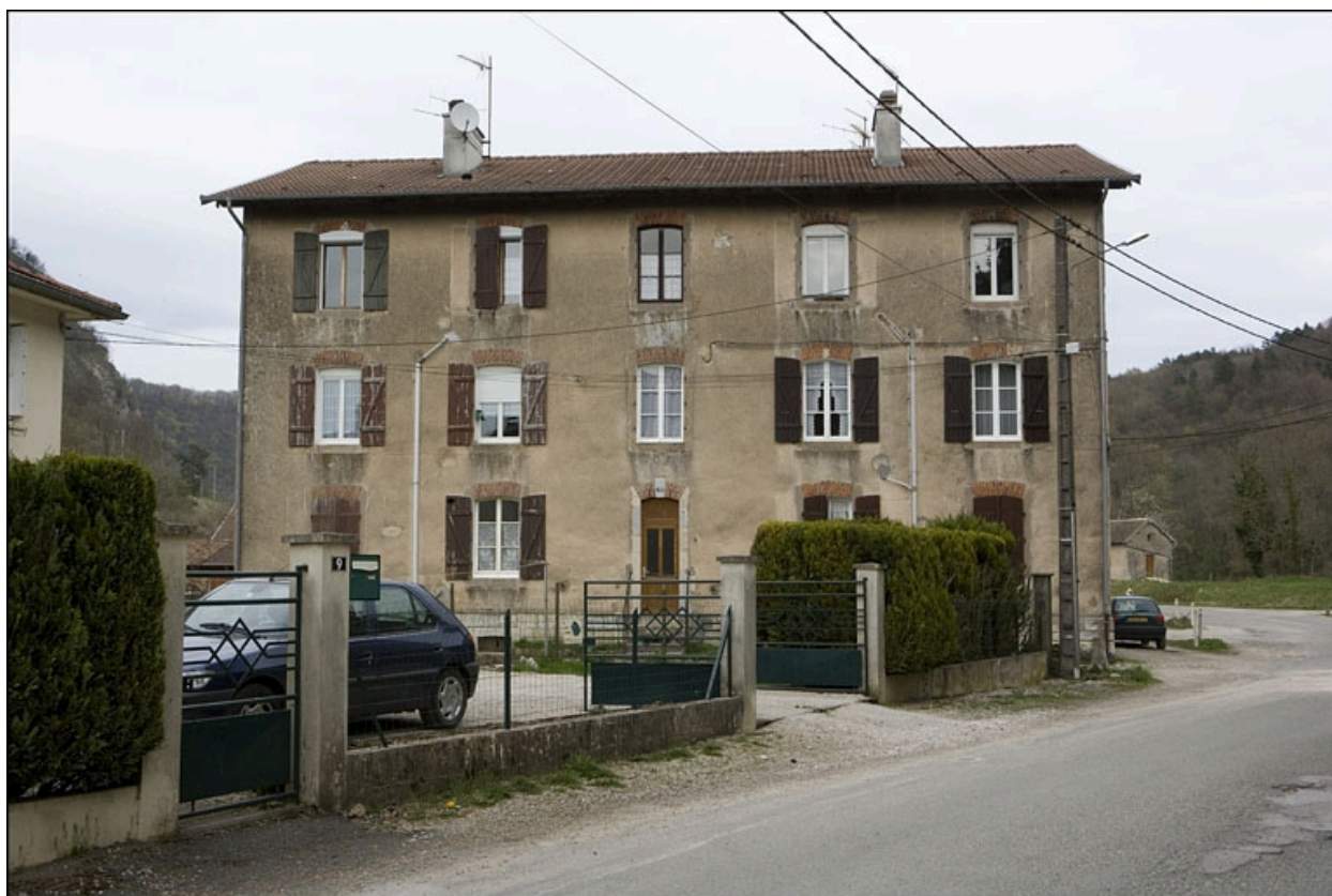
Cité ouvrière (rue des Ecoles). Façade sud.
