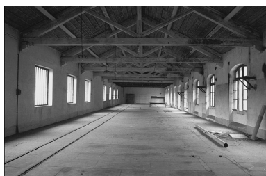
Intérieur de l'atelier de façonnage en 1980. Phot. Bernard Lardière IVR43_19802500391Z
