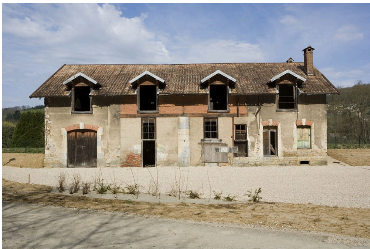
Façade est de l'écurie.
