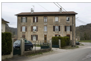
Cité ouvrière (rue des Ecoles). Façade sud.
