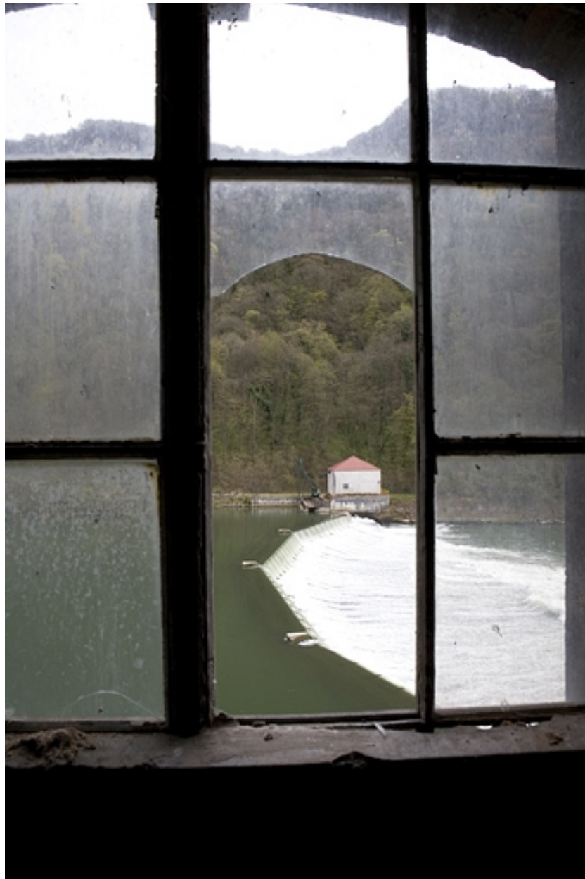
Vue du barrage depuis la rive droite.
