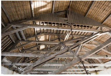
Atelier de préparation de la pâte. Eléments de la charpente (ferme effondrée au premier plan). Phot. Yves Sancey IVR43_20092500361NUC2A
