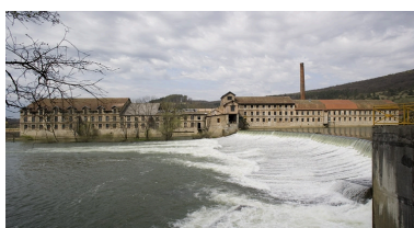
Vue d'ensemble depuis la chute. Phot. Yves Sancey IVR43_20092500320NUC2A
