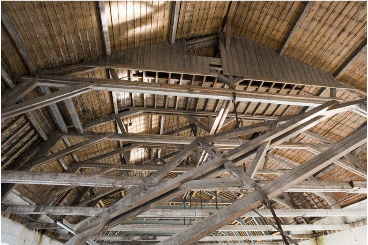
Atelier de préparation de la pâte. Eléments de la charpente (ferme effondrée au premier plan).
