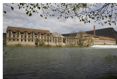
Vue d'ensemble depuis l'aval. Phot. Yves Sancey IVR43_20092500322NUC2A
