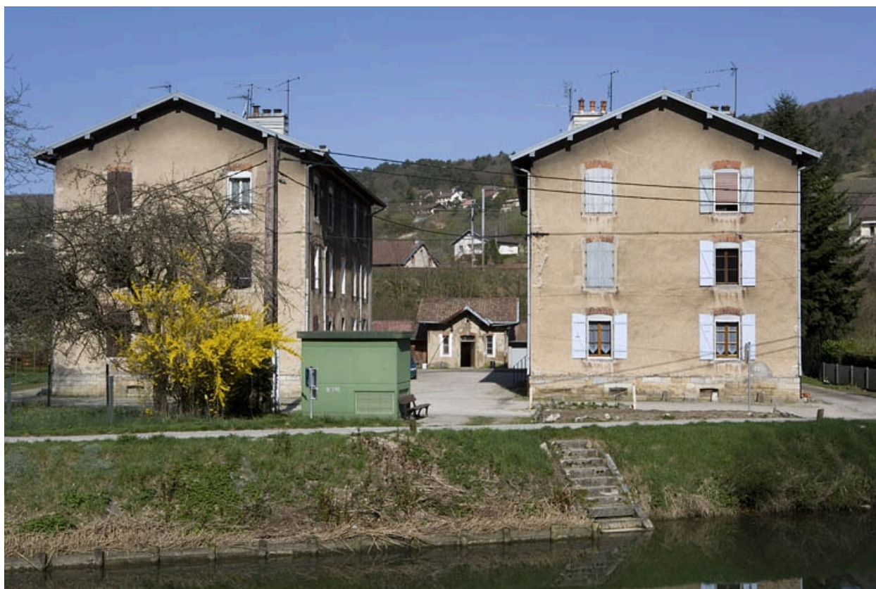
Cité ouvrière (rue des Ecoles). Pignons est.
