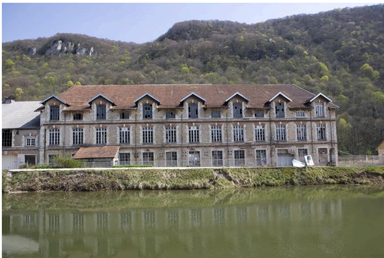
Façade antérieure de l'atelier de façonnage.
