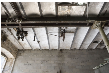
Bâtiment d'eau. Détail du plancher supérieur en entrecrois en berceau segmentaire. Phot. Yves Sancey IVR43_20092500350NUC2A
