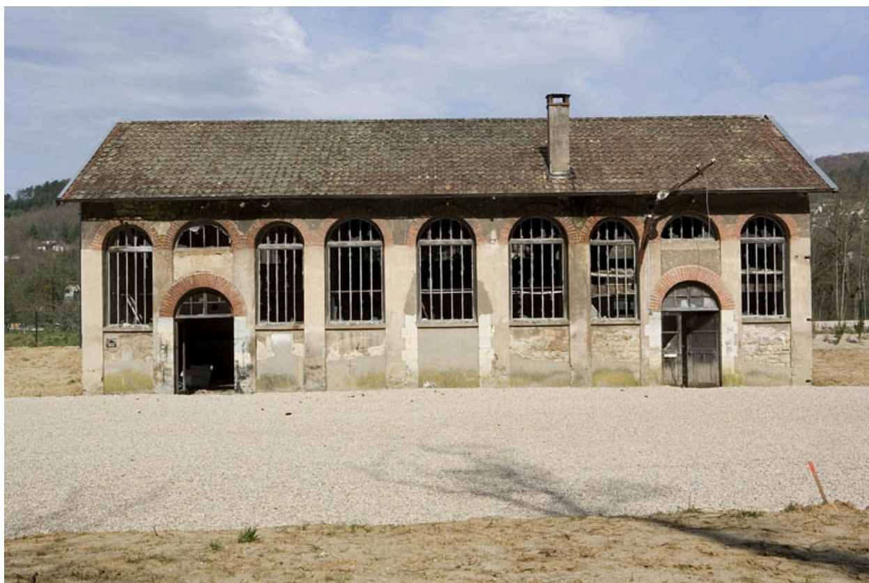
Façade est de l'atelier de réparation.
