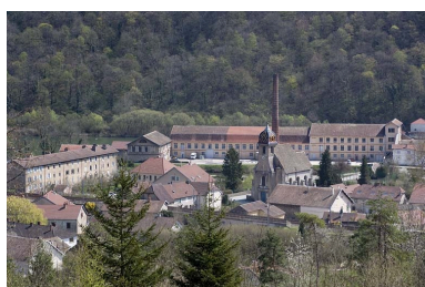
Vue générale rapprochée. Phot. Yves Sancey IVR43_20092500333NUC2A
