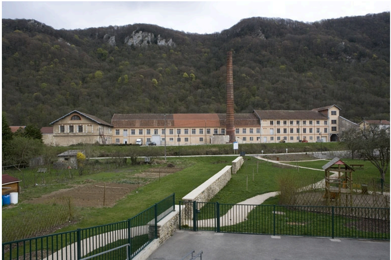
Façades ouest des ateliers.
