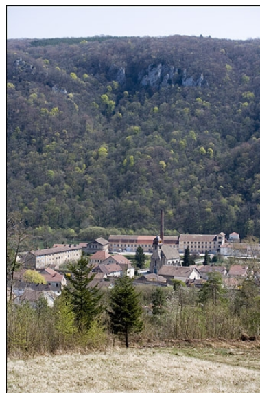
Vue plongeante depuis l'ouest. Phot. Yves Sancey IVR43_20092500334NUC2A
