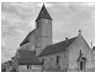
Façade occidentale, bas-côté et transept nord. Phot. Jean-Luc Duthu IVR26_19748901108V
