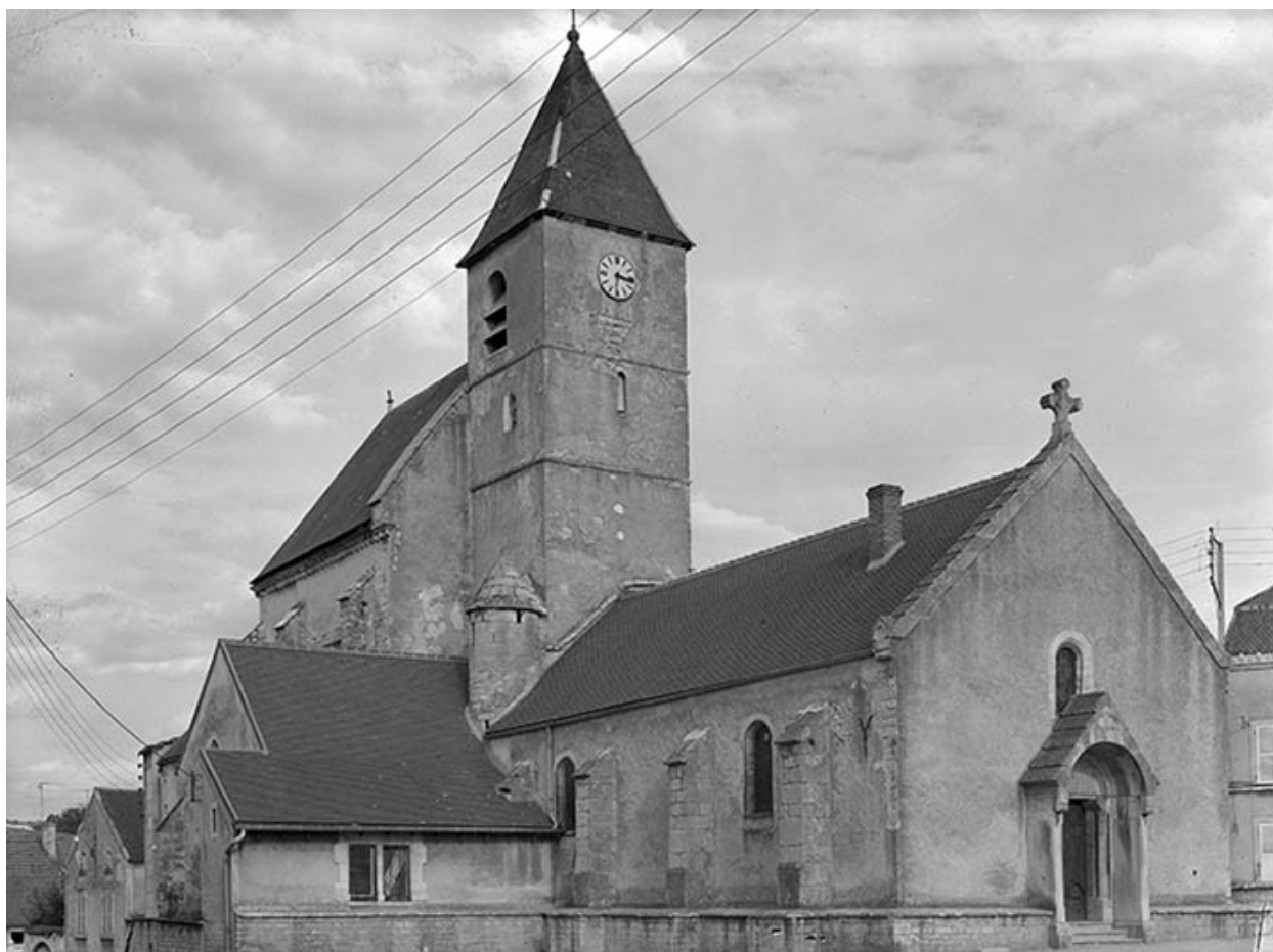
Façade occidentale, bas-côté et transept nord.
