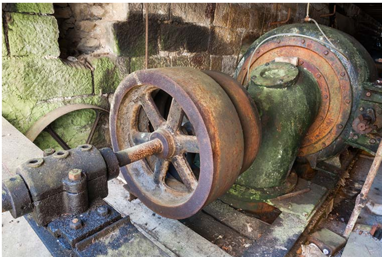
Turbine hydraulique (partie supérieure).
