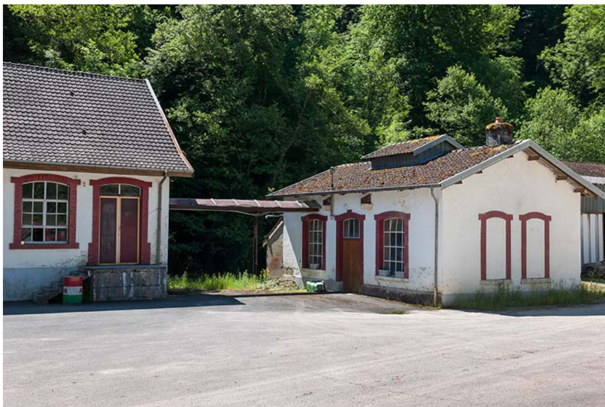
bâtiment de la forge.
