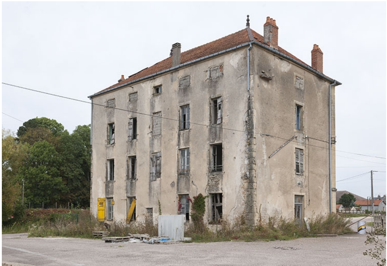
Façade postérieure de trois quart droit.
