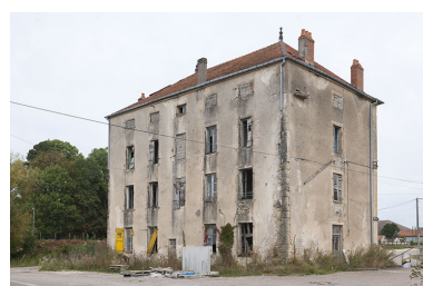
Façade postérieure de trois quart droit. Phot. Jérôme Mongreville IVR43_20127000639NUC4A
