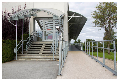
Façade latérale droite : escalier et rampe d'accès. Phot. Sonia Dourlot IVR43_20142501736NUC2A
