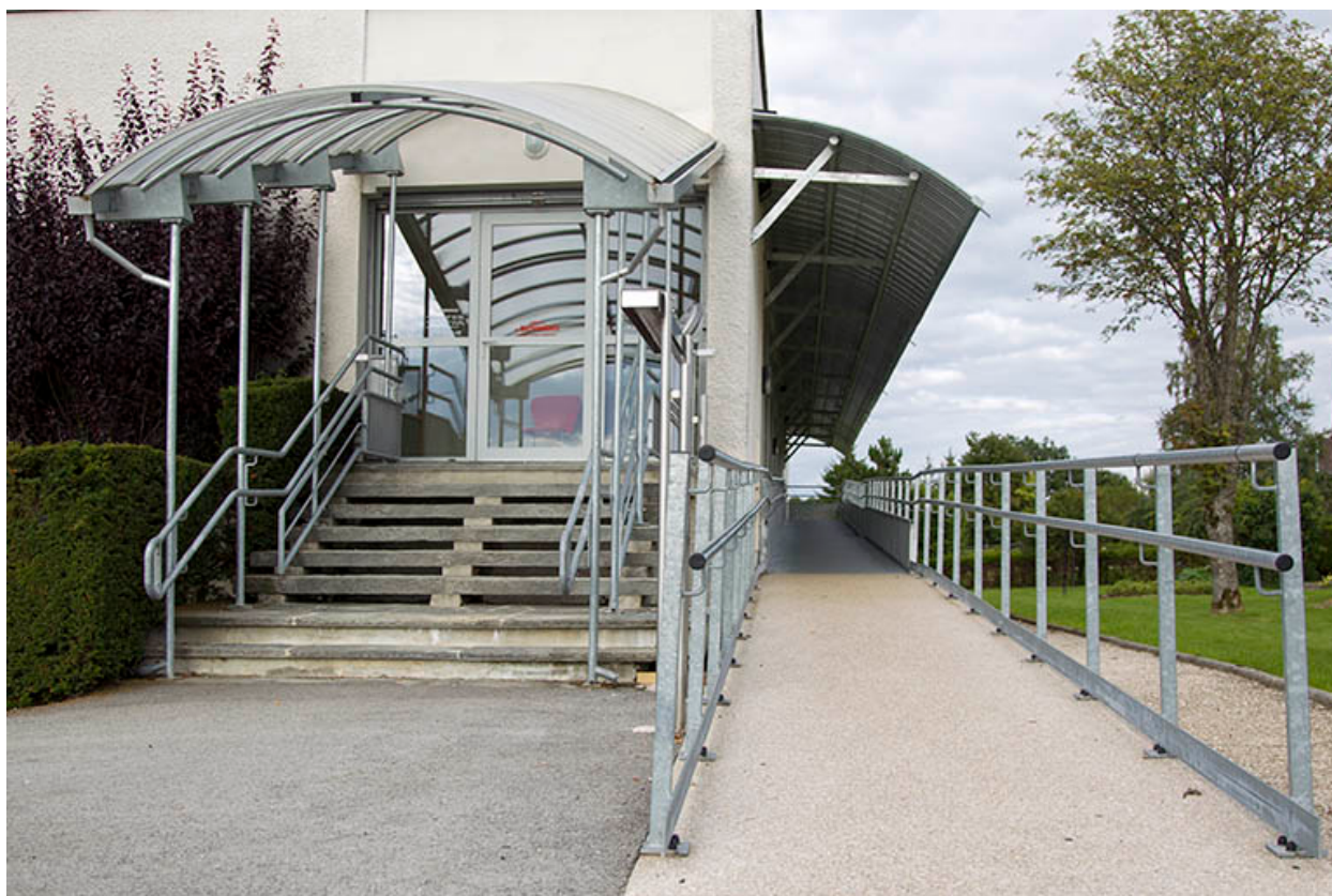
Façade latérale droite : escalier et rampe d'accès.
