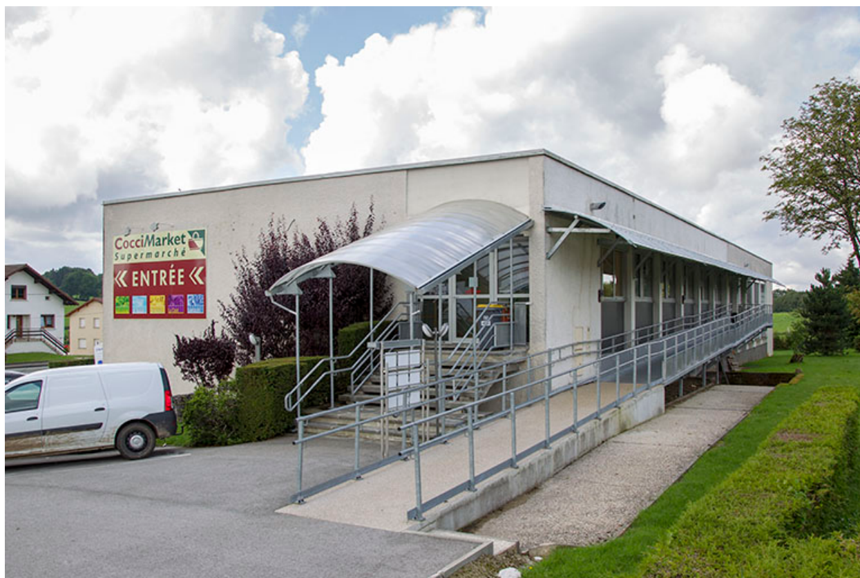
Façades latérale droite et postérieure.
