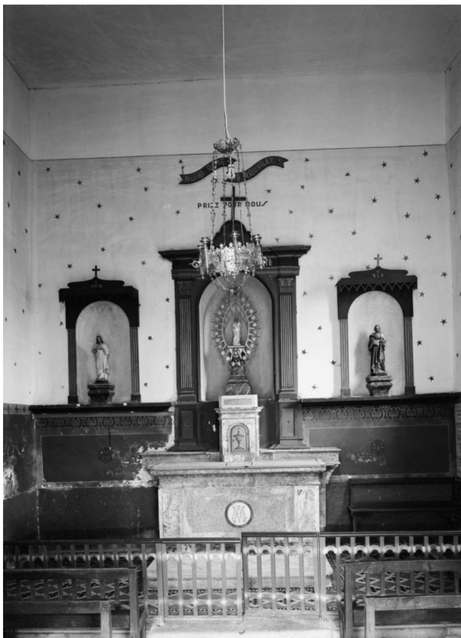
Vue de l'intérieur, depuis l'entrée.
