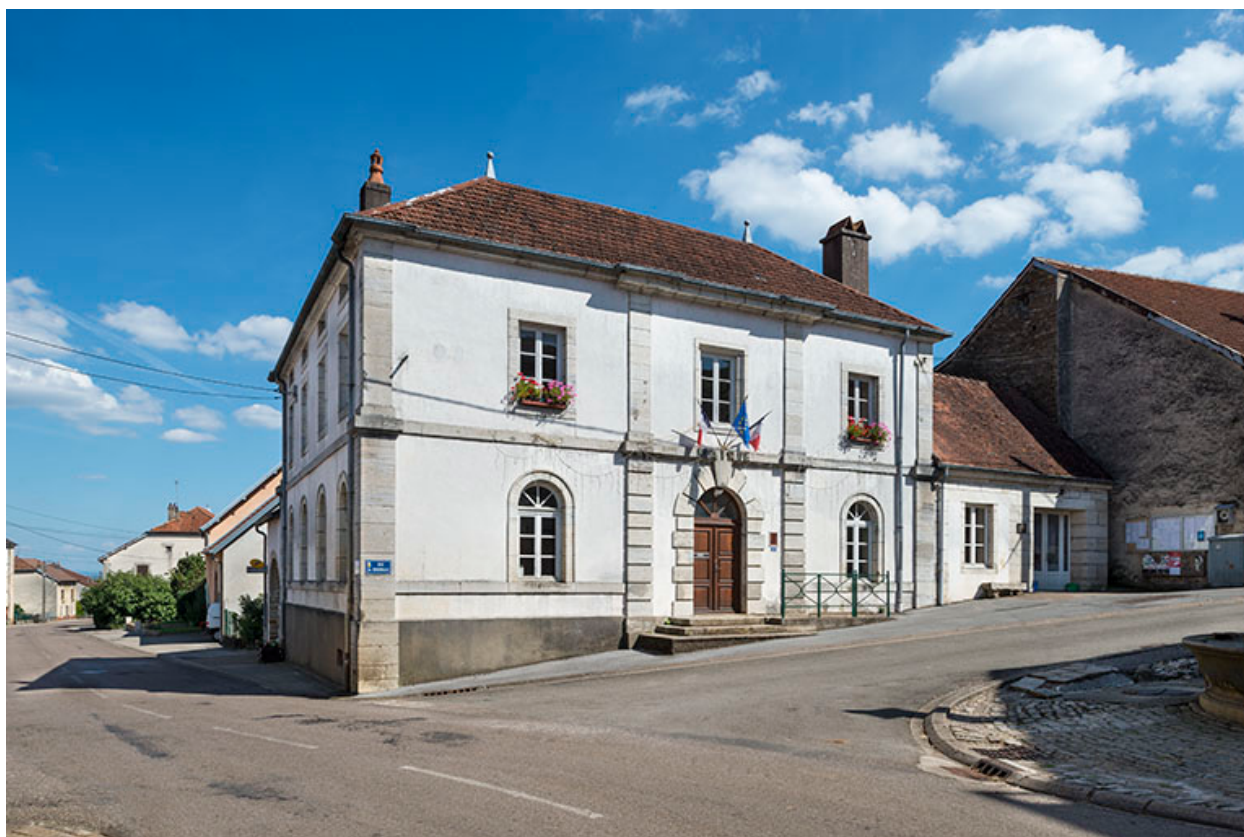
Vue depuis la Grande Rue.
