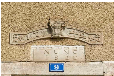
Détail d'une date portée, ancien presbytère. Phot. Sonia Dourlot IVR43_20157001133NUC2A
