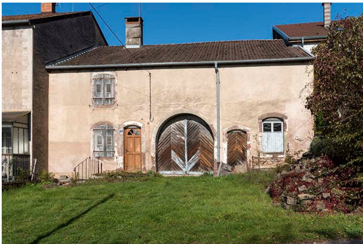
Ferme, rue de la Forge.
