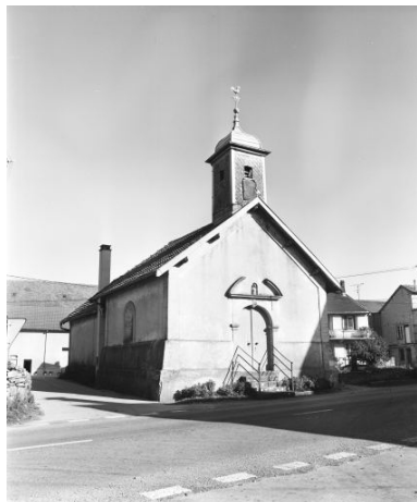
Vue de la façade antérieure. Phot. Yves Sancey IVR43_19783900062X
