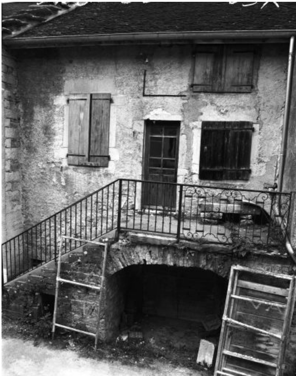
Façade antérieure vue de face en 1981.
