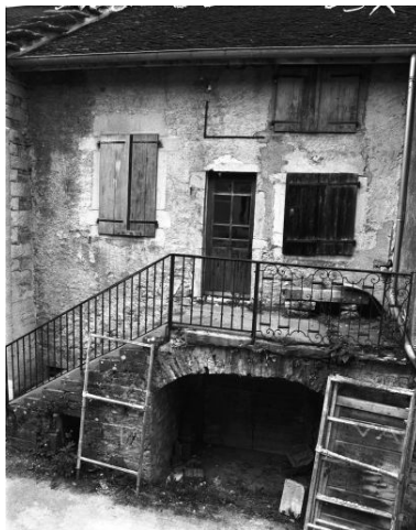
Façade antérieure vue de face en 1981. Phot. Yves Sancey IVR43_19813900139X
