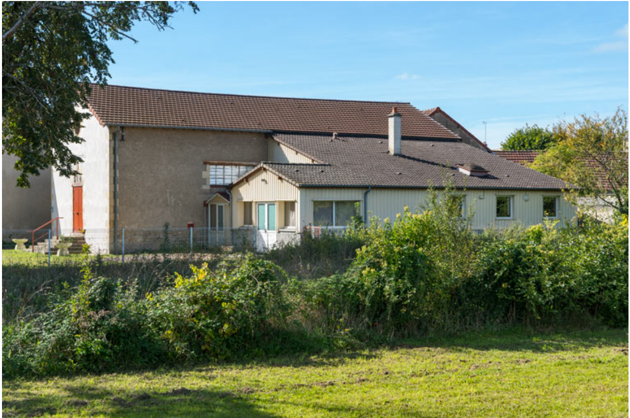
Façade latérale droite, de trois quarts gauche.
