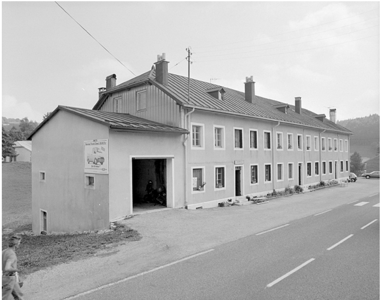
Logement d'ouvriers, vu de trois quarts gauche.
