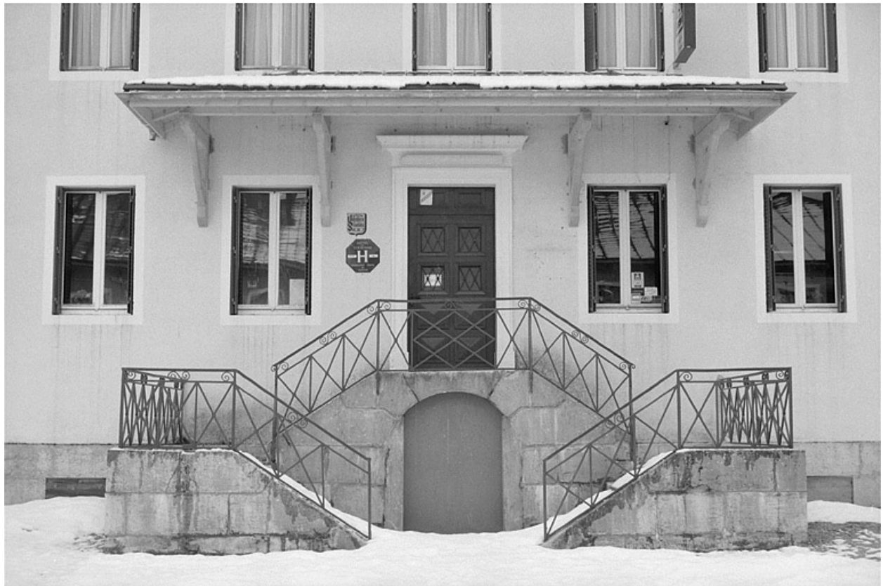
Escalier extérieur de l'atelier de fabrication.
