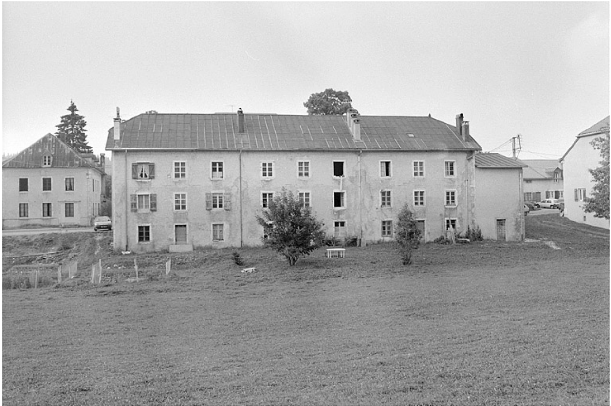
Façade postérieure du logement d'ouvriers.
