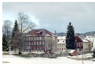
Vue d'ensemble depuis le sud-est, en hiver. Phot. Laurent Poupard IVR43_19913901062ZA
