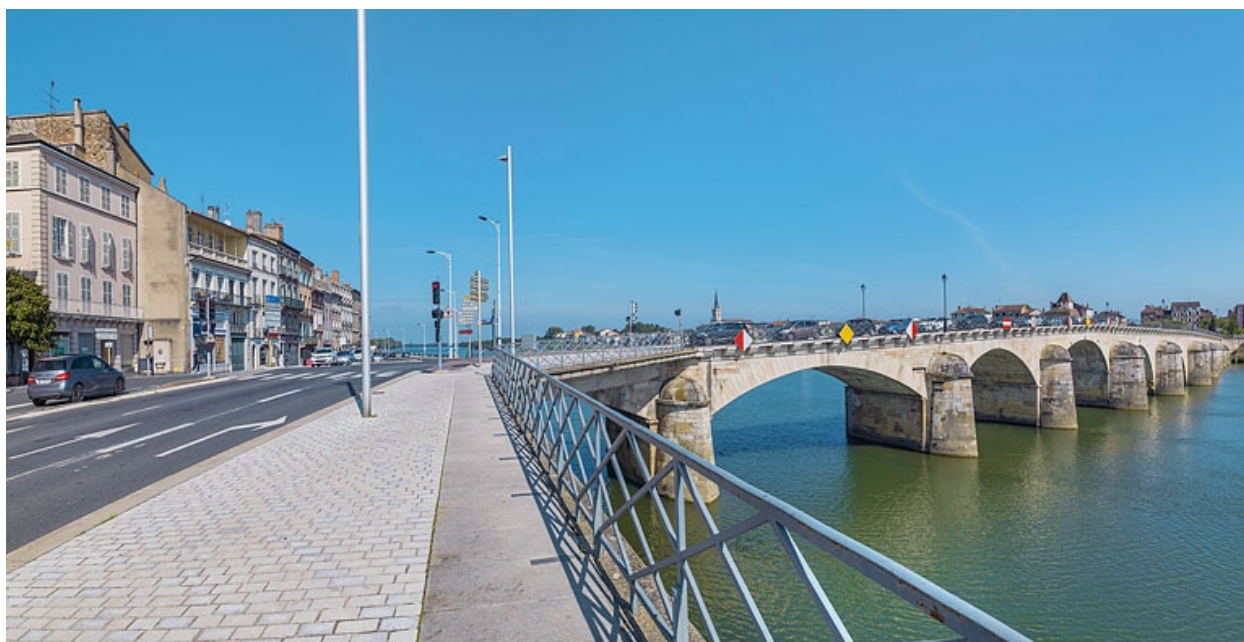
Le pont Saint-Laurent, vu d'aval, rive droite.
