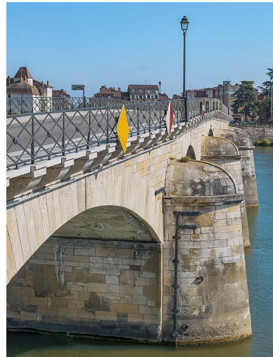
Détail des arrière-becs du pont. Phot. Thierry Kuntz IVR26_20217100567NUC4A
