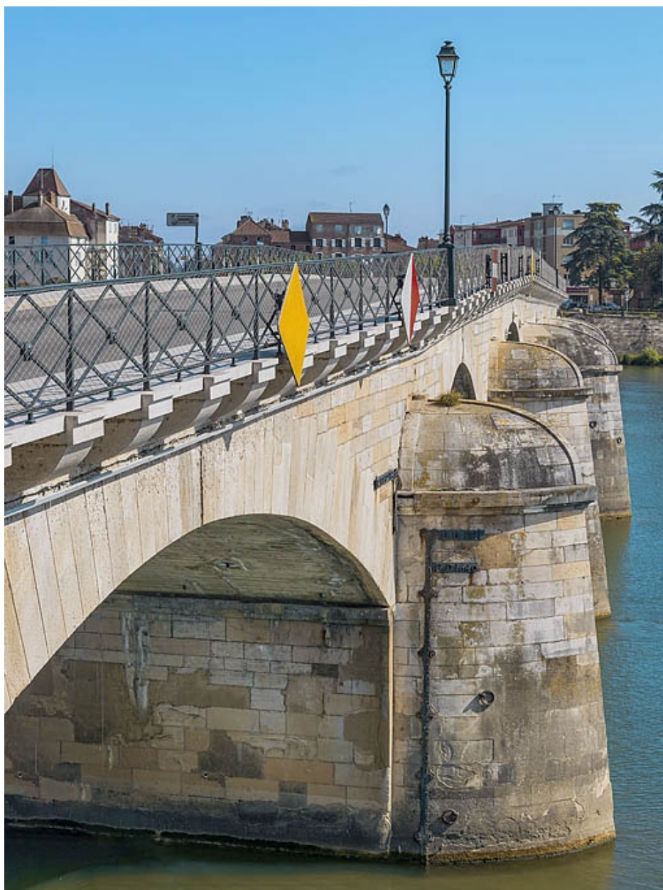
Détail des arrière-becs du pont.
