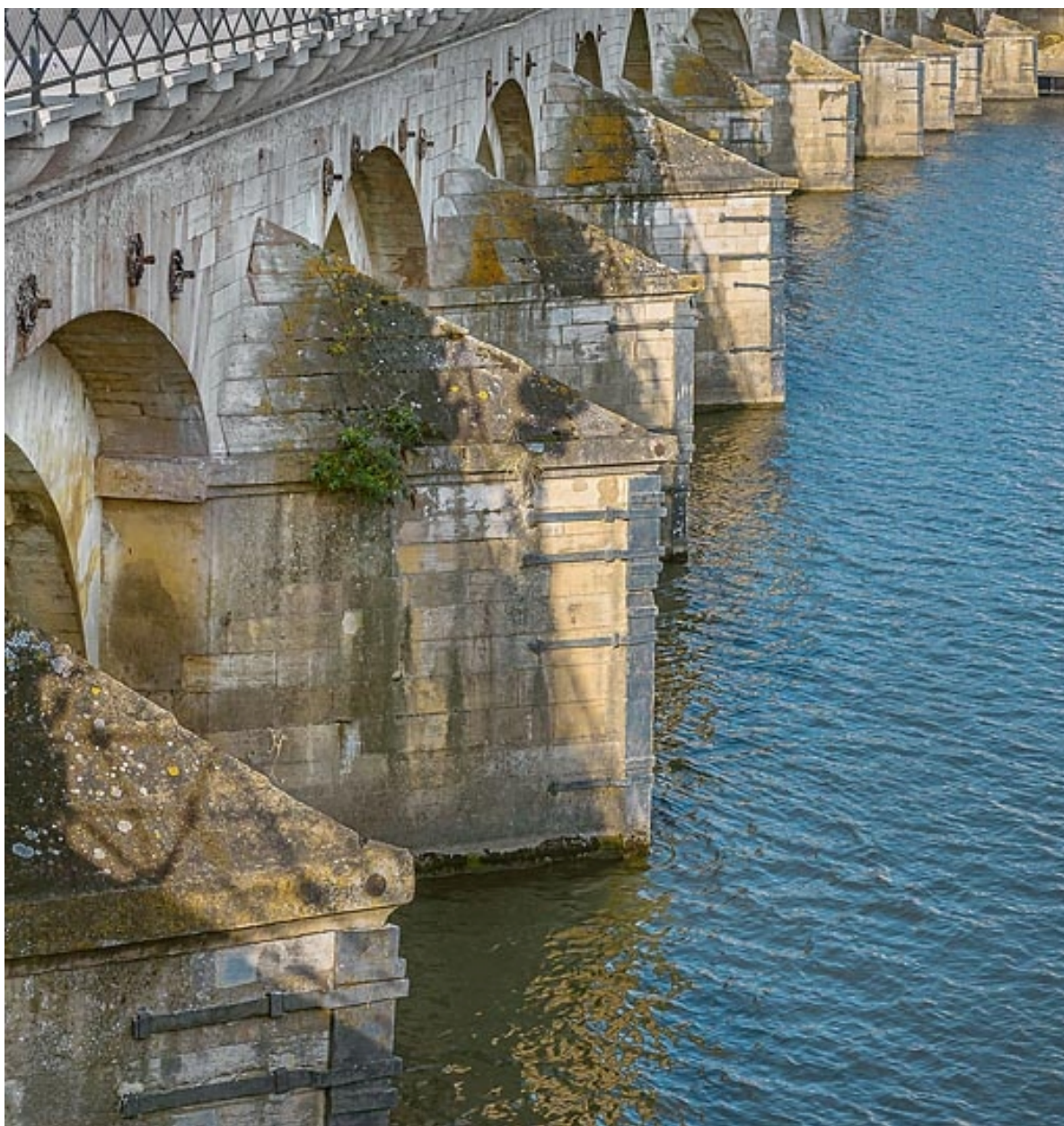
Les avant-becs du pont Saint-Laurent.
