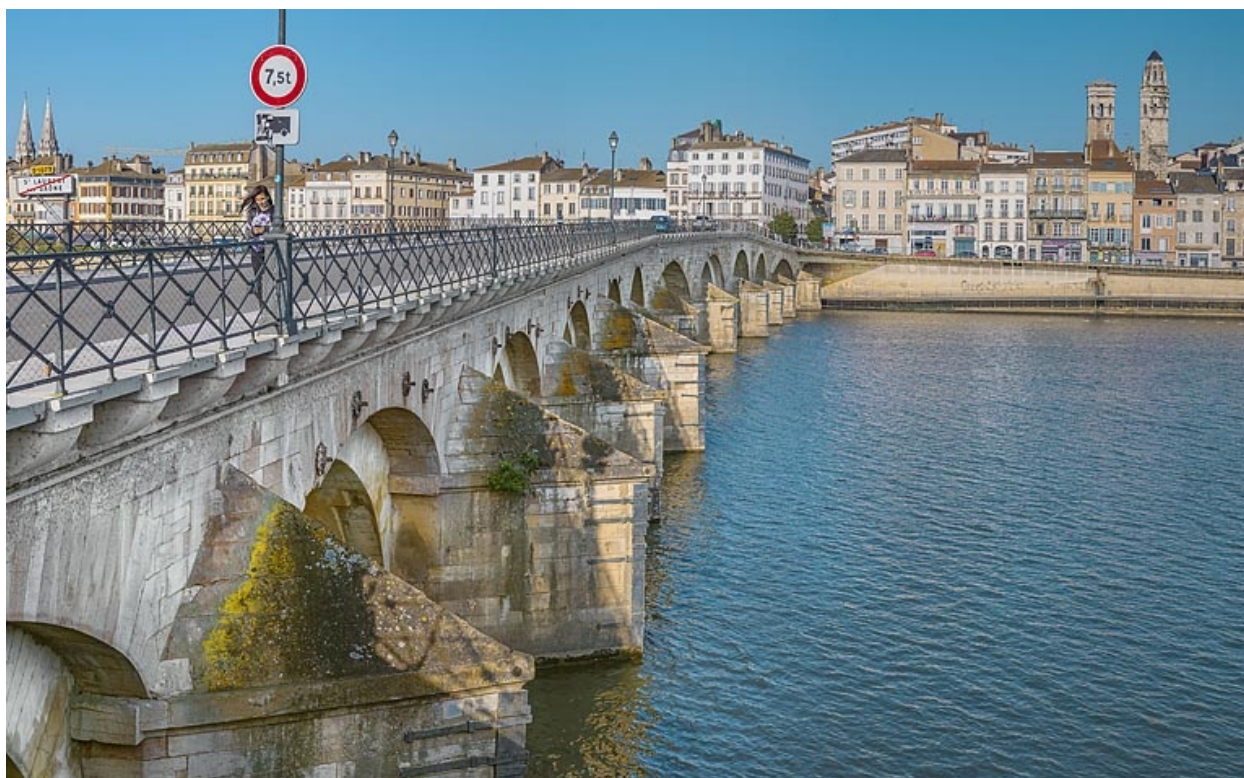
Les avant-becs du pont Saint-Laurent.
