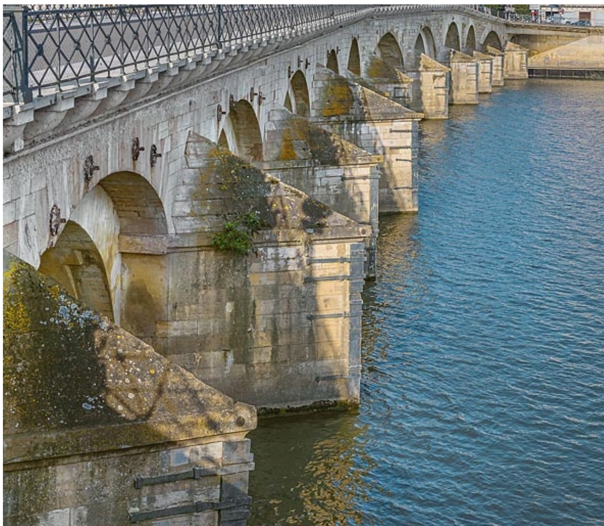
Les avant-becs du pont Saint-Laurent.
