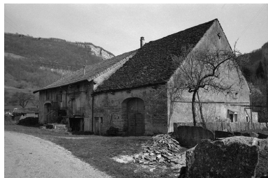
Façades antérieure et latérale droite en 1974.
