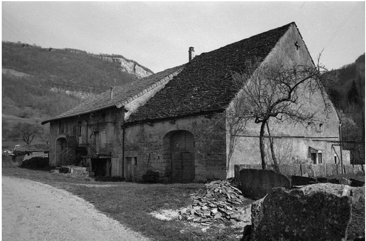
Façades antérieure et latérale droite en 1974.
