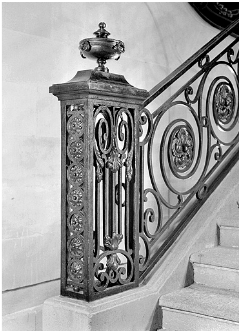
Détail, départ de la rampe gauche.
