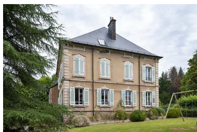
Façade sud, vue depuis le jardin. Phot. Jérôme Mongreville IVR43_20207000499NUC4A
