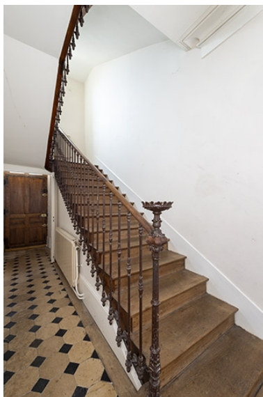
Escalier rampe-sur-rampe avec repos formant retour complet à gauche, vue depuis le palier du rez-de-chaussée. Phot. Jérôme Mongreville IVR43_20207000505NUC4A
