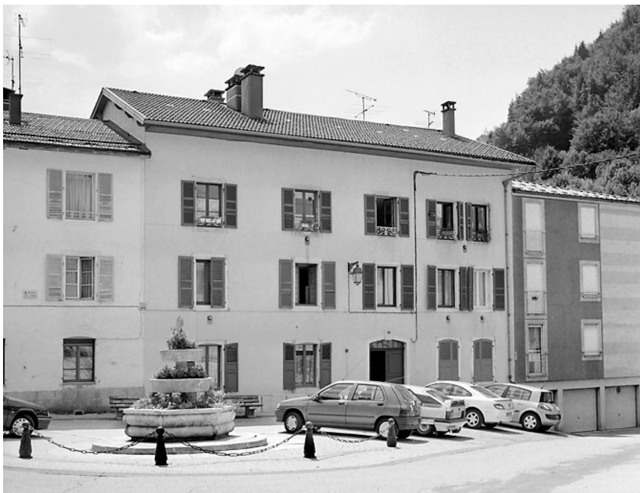
Elévation antérieure, de trois quarts gauche.
