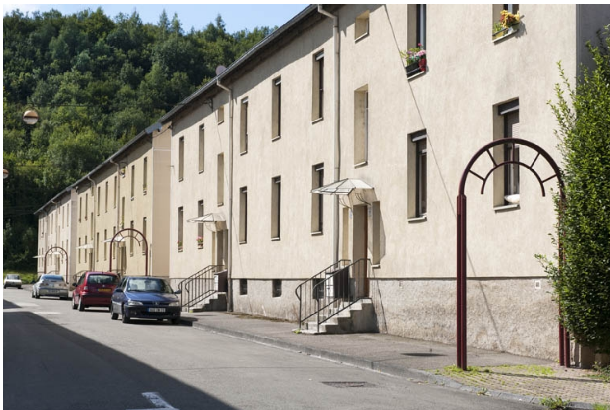
Façade antérieure des habitations.
