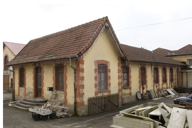
Bâtiments techniques. Phot. Jérôme Mongreville IVR43_20067000152NUCA
