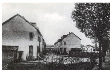
Cité ouvrière du Pâquis. Phot. Jérôme Mongreville IVR43_20067000201NUCA
