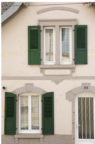
Détail de façade de la conciergerie. Phot. Jérôme Mongreville IVR43_20067000145NUCA
