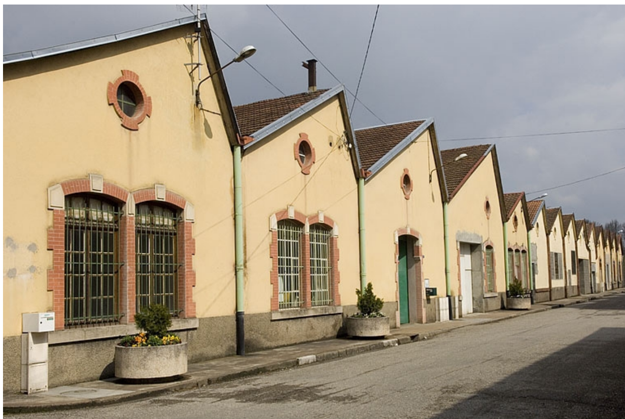
Pignons de sheds.
