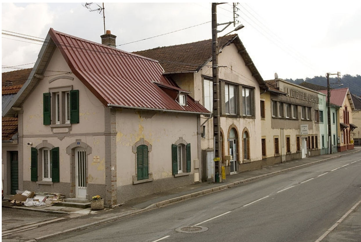
Façades sur l'avenue Jean Jaurès.
