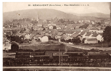
Héricourt (Haute-Saône) - Vue générale. Phot. Jérôme Mongreville IVR43_20057000590NUCA
