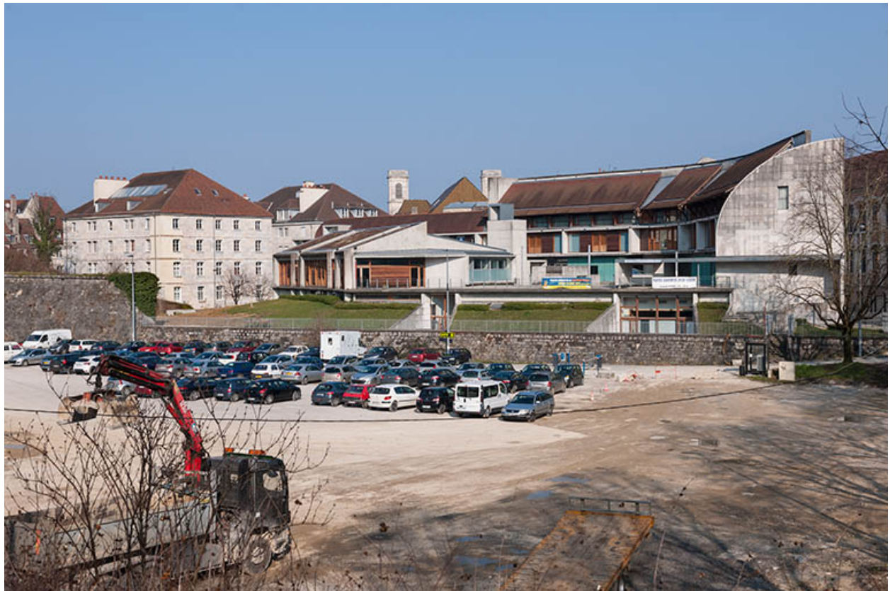
Besançon, lycée Condé : vue depuis le sud-ouest.
