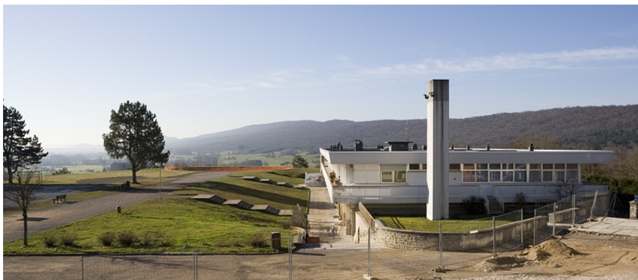
Crotenay, lycée d'enseignement adapté : vue d'ensemble.
