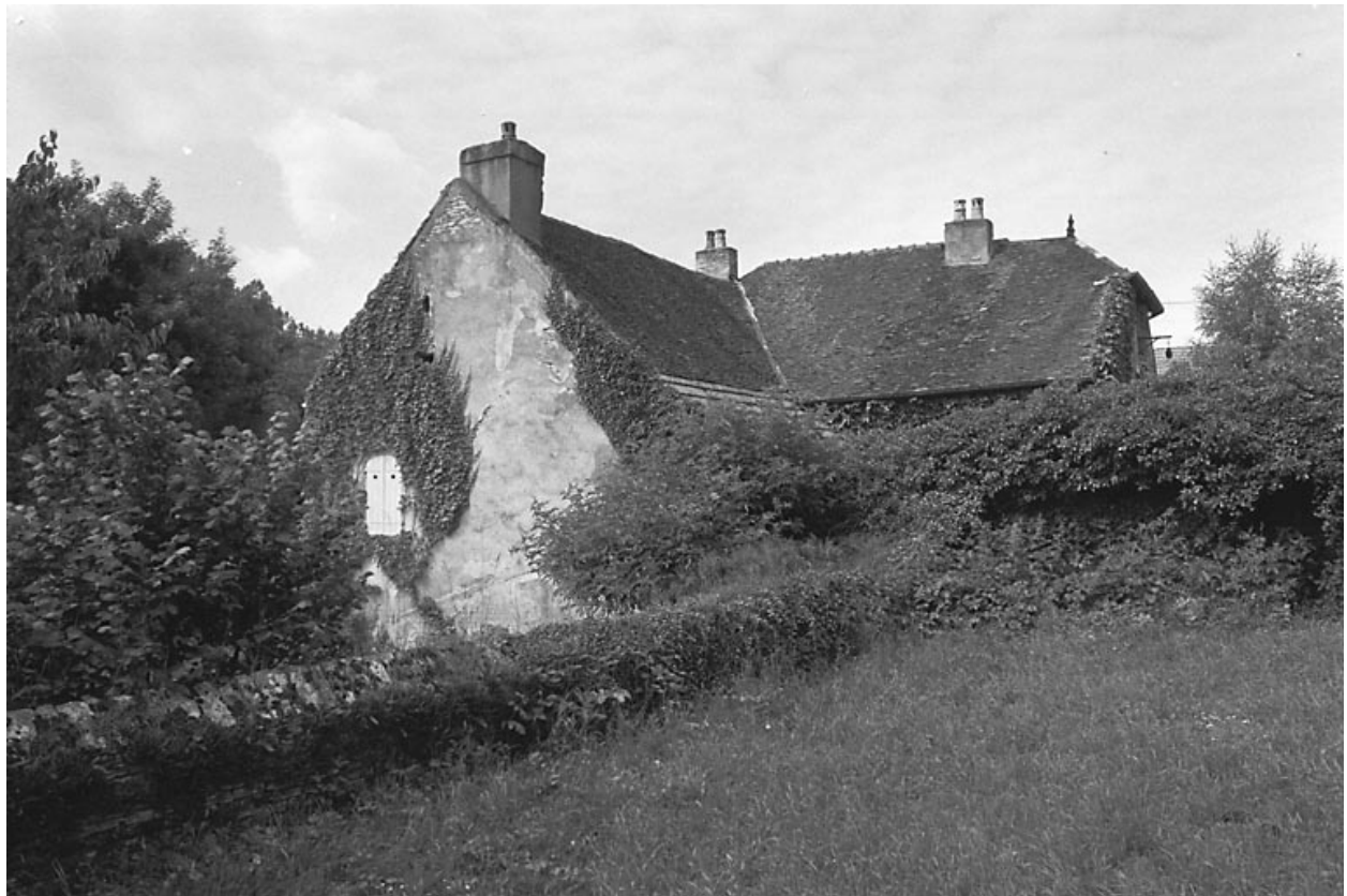
Vue d'ensemble depuis le parvis de l'église.
