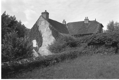
Vue d'ensemble depuis le parvis de l'église. Phot. Bernard Lardière IVR43_19817000239Z
