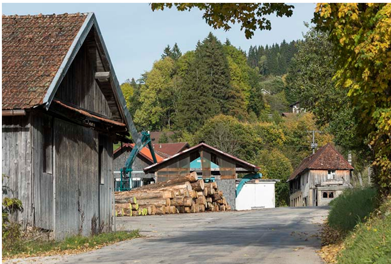
Vue d'ensemble depuis la route, au sud-ouest.
