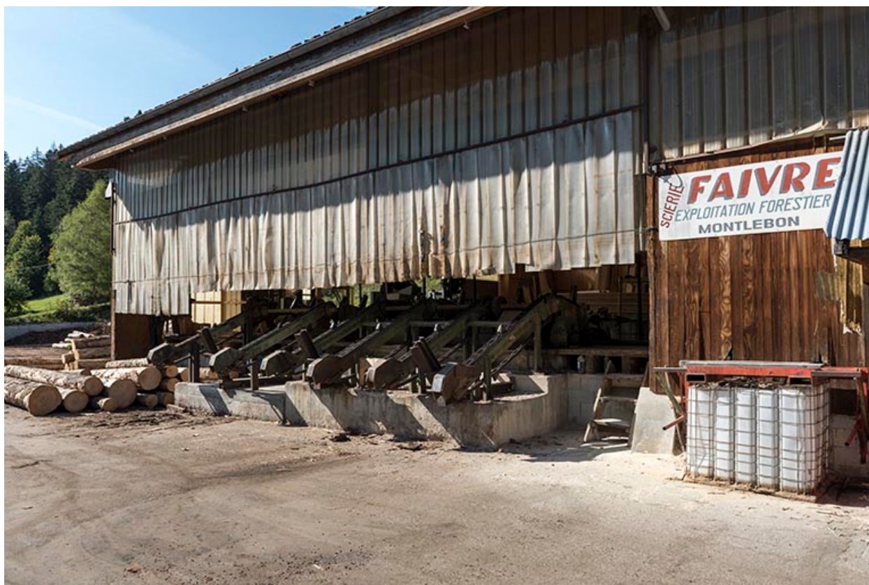
Atelier de fabrication (2000) : façade sud.
