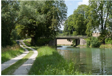
Vue du pont.
