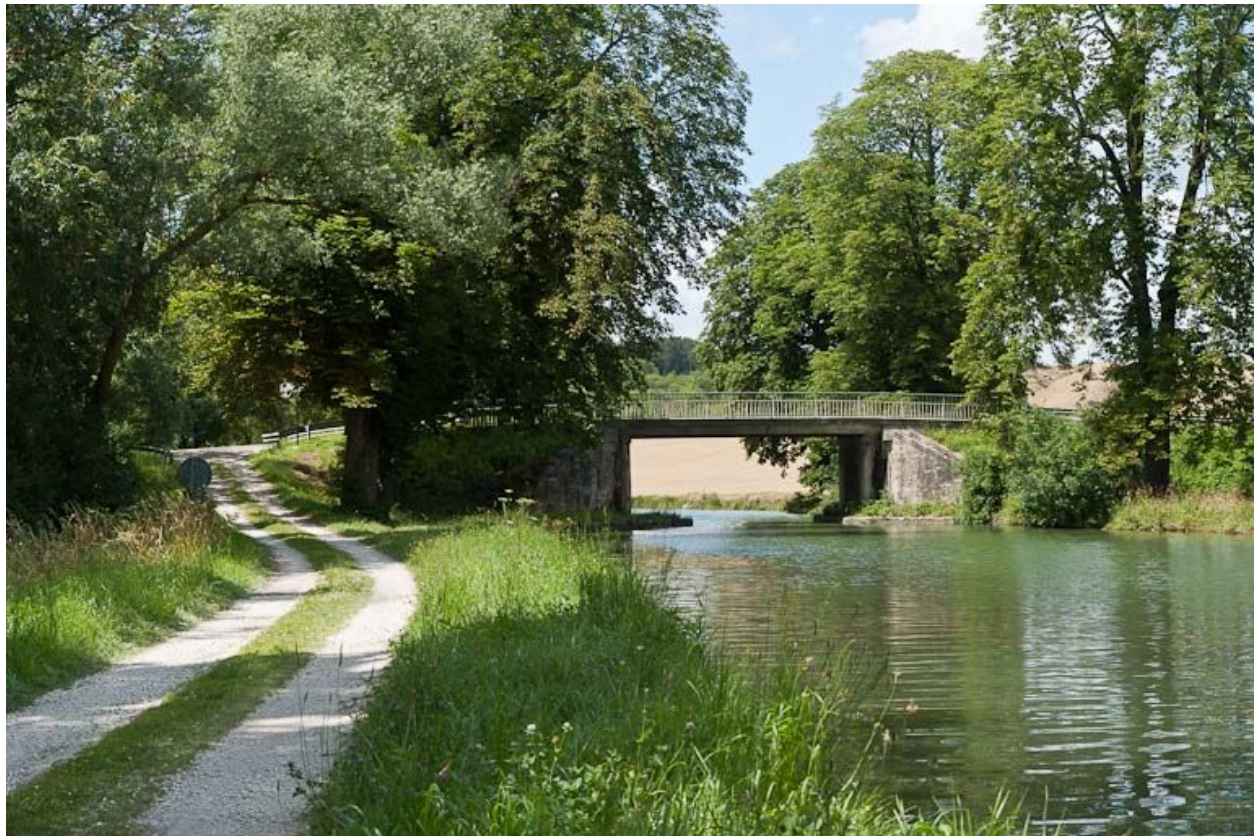
Vue du pont.
