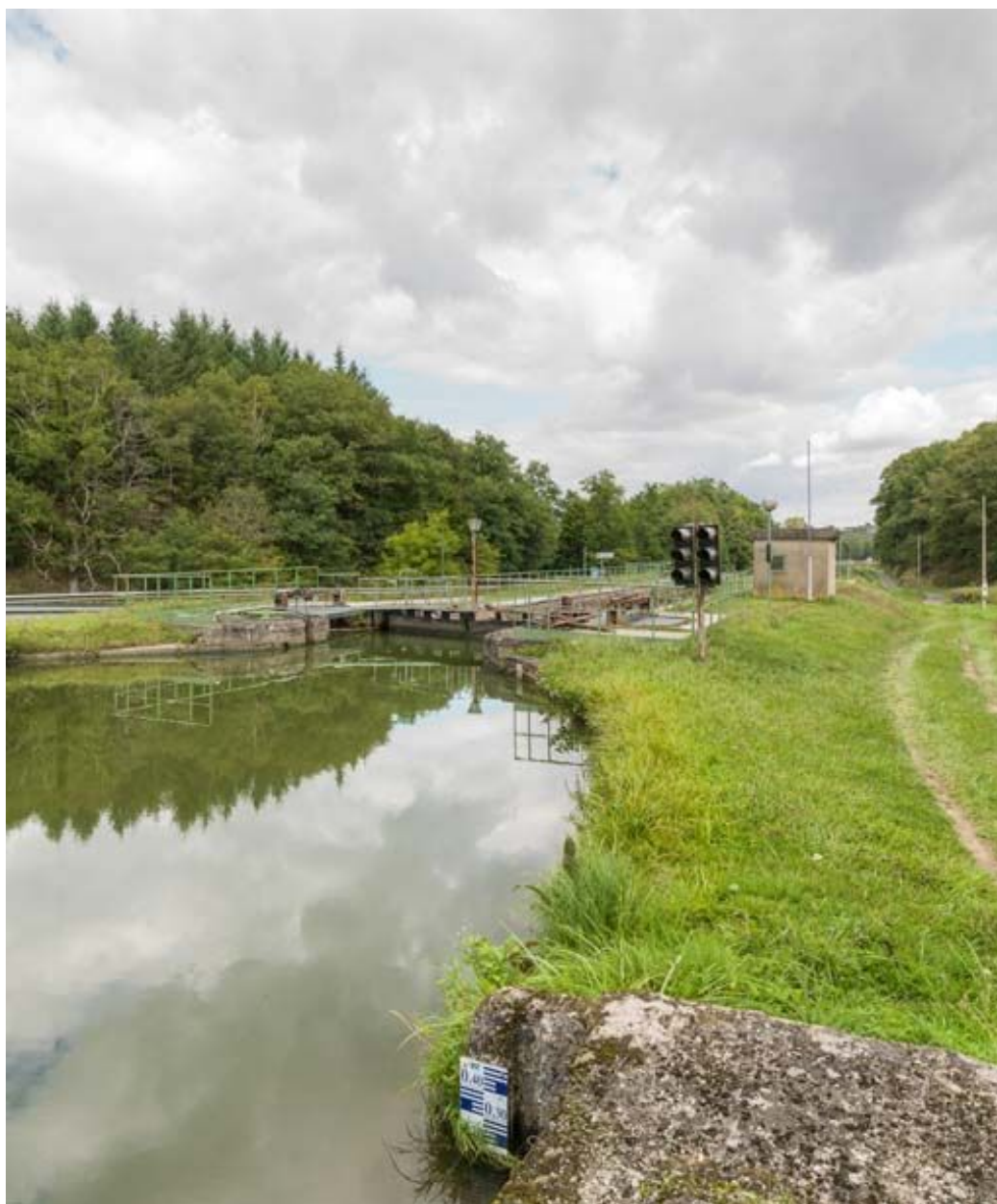
Vue d'ensemble du site d'écluse.
